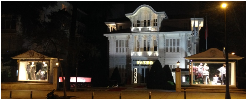
Şekil 2.29 : Ada Şeklinde Vitrin, Vakko Mağazası (Bağdat Caddesi-İstanbul, 2015, Ayda Gelgör)
