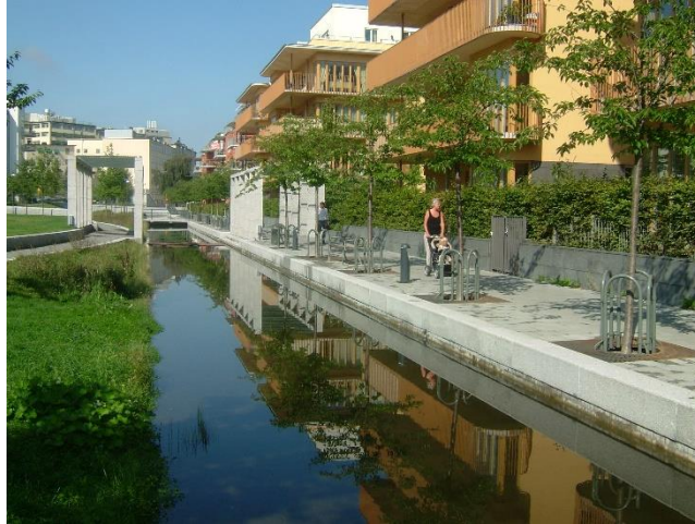
Şekil 3.4.2 Yağmur sularının toplandığı kanal örneği (Kaynak: URL-21, 10 Nisan 2016)
