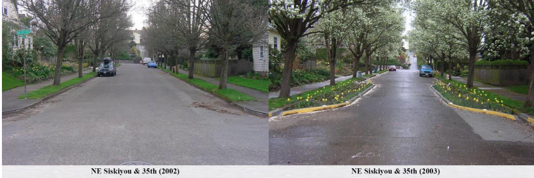
Şekil 3.1.6 Kaldırım uzantısı örneği (Kaynak: Wethington,2015)
