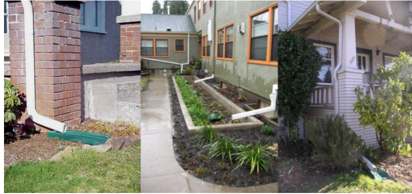
Şekil 3.1.1 Portland disconnected downspout uygulamaları (Kaynak: Wethington,2015)
