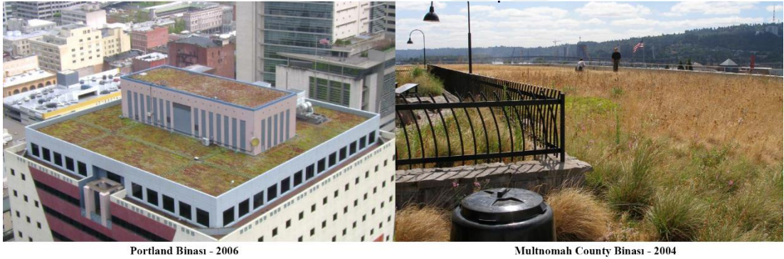
Şekil 3.1.13 Çatı bahçesi örnekleri (Kaynak: Wethington,2015)
