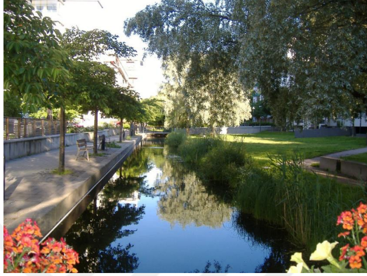
Şekil 3.2.6 Yağmur suyu yönetiminde yer alan kanal örneği (Kaynak: URL-18, 2 Nisan 2016)
