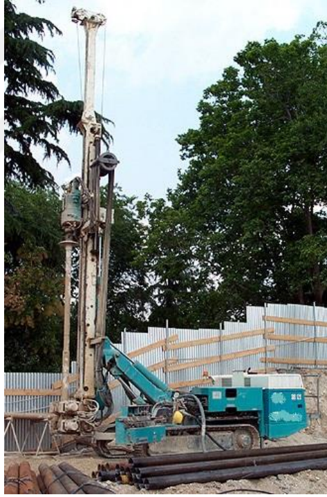
Şekil 2.12 : Jet grout delgi ekipmanı [6].
