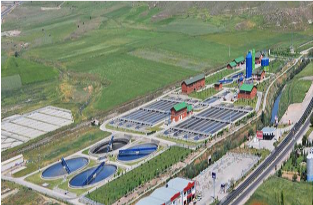
Şekil 3.5: Kayseri ileri biyolojik atıksu arıtma tesisi.
