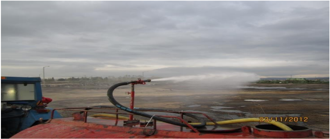
Şekil 4.5: Koku problemiyle mücadele çalışmaları
