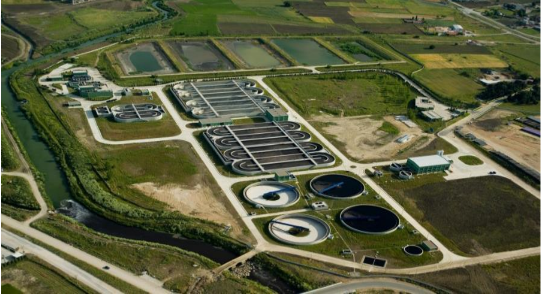
Şekil 3.2: BUSKİ batı atıksu arıtma tesisi.
