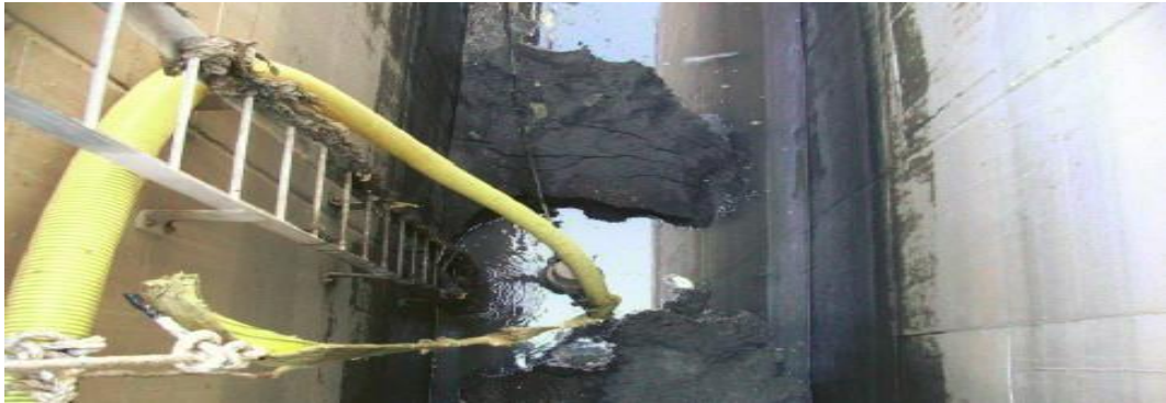
Şekil 4.9: Izgara kanalında biriken kum.
