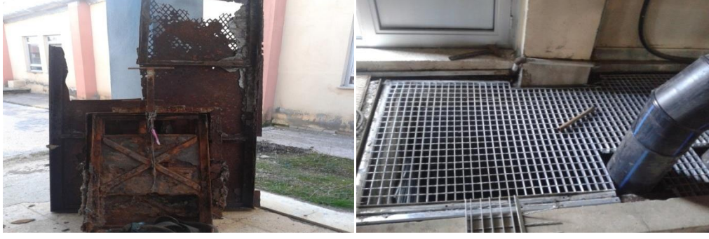
Şekil 4.8: Çürümüş demir kapaklar ve galvaniz kaplı paslanmaz yeni kapaklar
