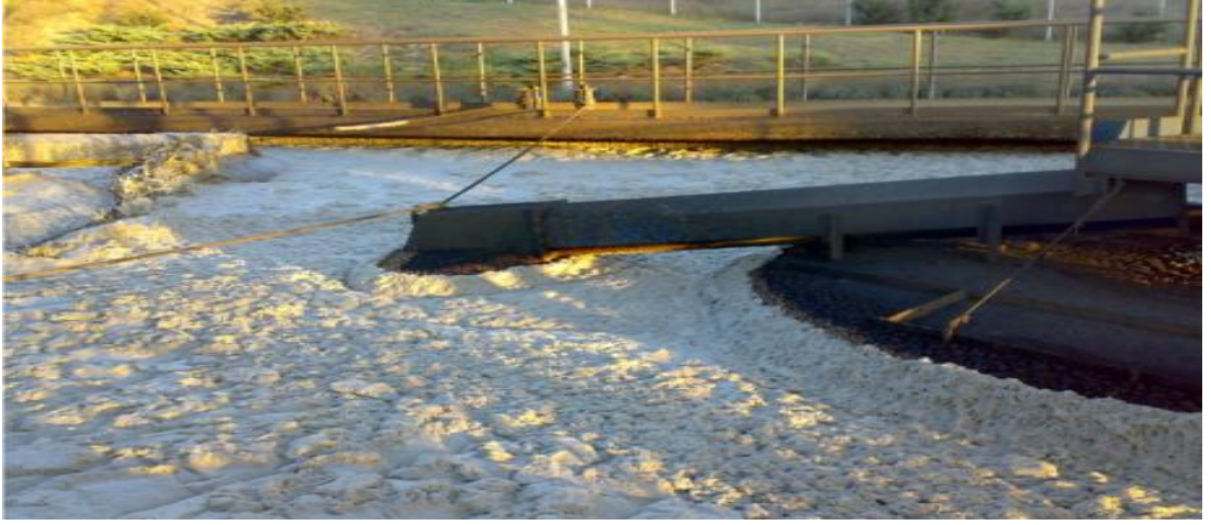
Şekil 4.2: Tesiste oluşan köpük.
