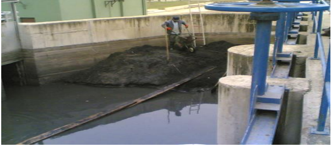
Şekil 2.10: Kum tutucudaki birikimler.
