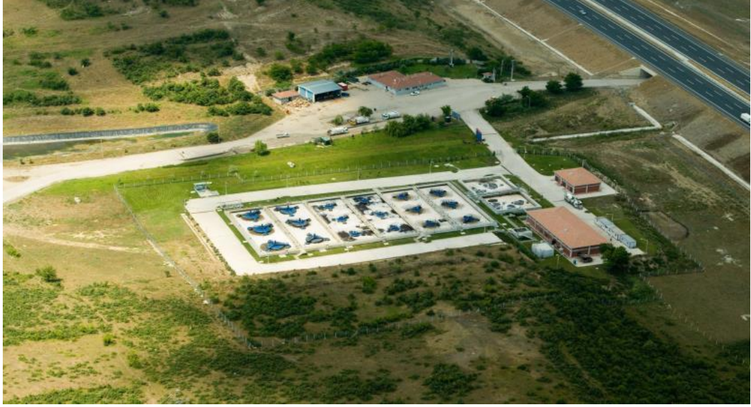
Şekil 3.3: BUSKİ kent katı atık depolama alanı süzüntü suyu arıtma tesisi.
