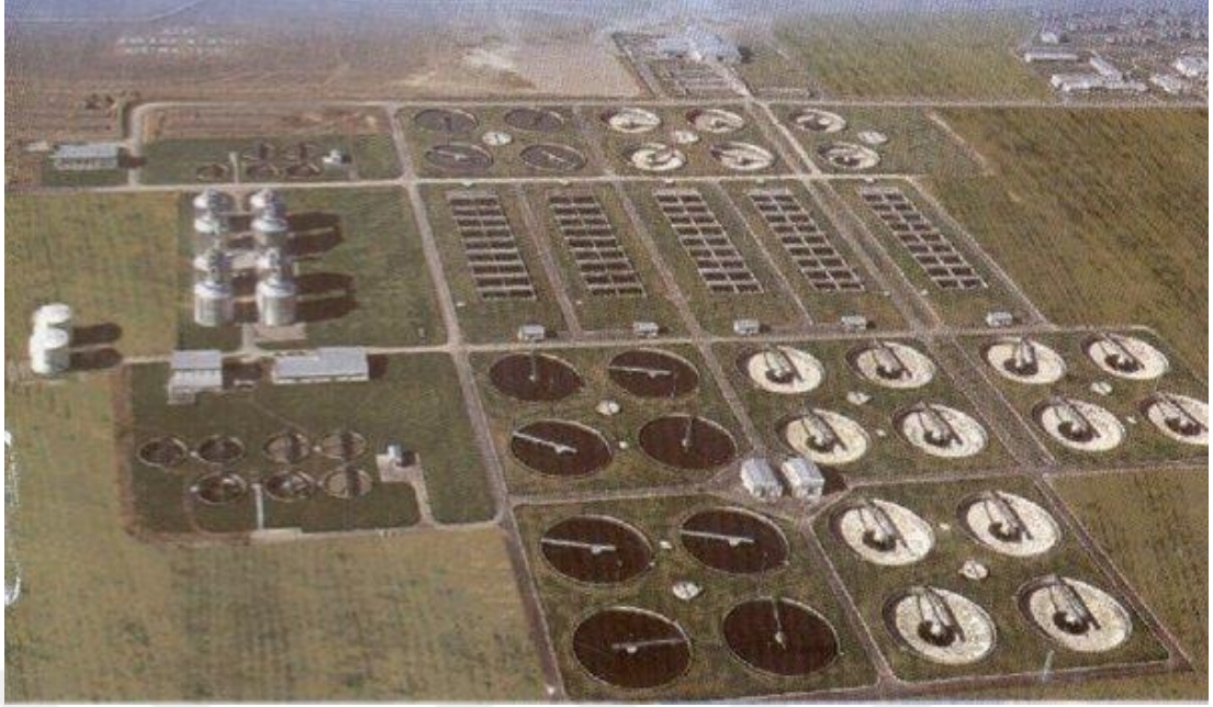
Şekil 3.4: Ankara atıksu arıtma tesisi.
