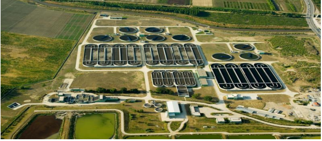
Şekil 3.1: BUSKİ doğu atıksu arıtma tesisi.
