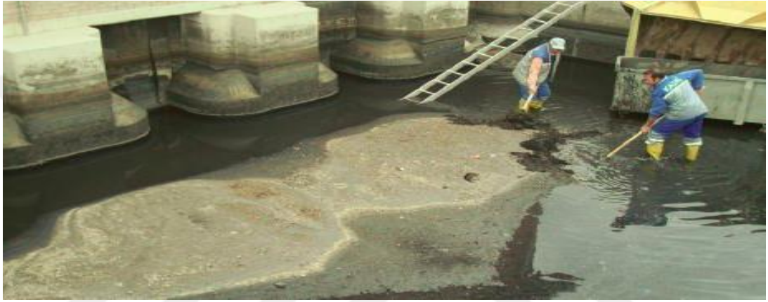
Şekil 4.10: Tabanda biriken kumun temizlenmesi
