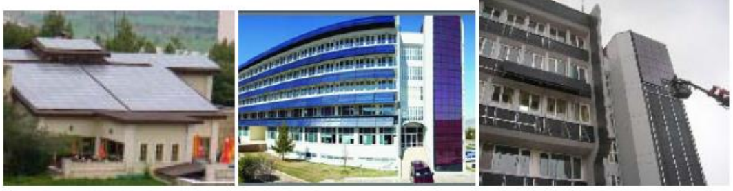
Şekil 5.2. Muğla Üniversitesi'nde gerçekleştirilen fotovoltaik entegre edilmiş çatı ve cephe uygulamaları
