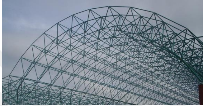
Şekil 5.10. Uzay kafes sistemi
