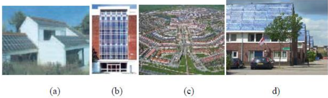
Şekil 5.1. Almanya’da gerçekleştirilen ilk yapı elemanları ile bütünleştirilmiş fotovoltaik çatı ve cephe uygulamaları:a,b,c,d (Mutlu, 2010)
