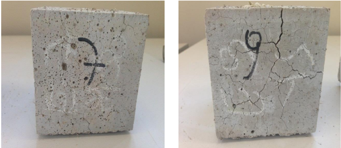
Şekil 4.19 800°C sonrasında numune yüzeylerinde meydana gelen makro çatlakların görünümü
