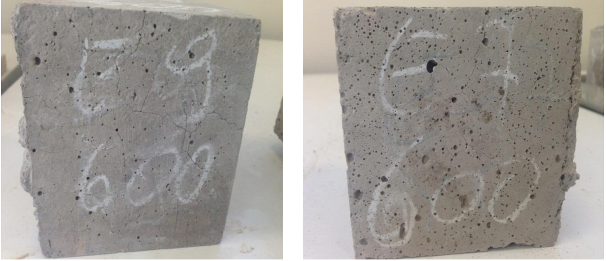
Şekil 4.18. 600°C sonrasında numune yüzeylerinde meydana gelen yoğun mikro çatlakların görünümü
