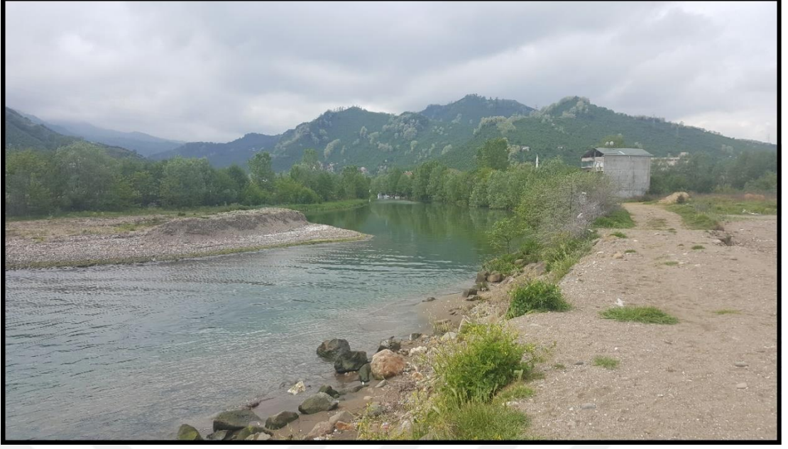
Şekil 3. Turnasuyu'nun ağız kısmında erozyonel nedenlerden ötürü mendirekler inşa edilmiştir (1 Mayıs 2016).
