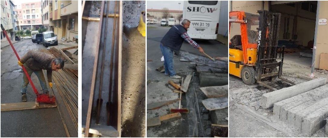
Şekil 2.2 Donatı hazırlanışı, kalıplara yerleştirilmesi ve söküm işlemi, kirişlerin laboratuara taşınması
