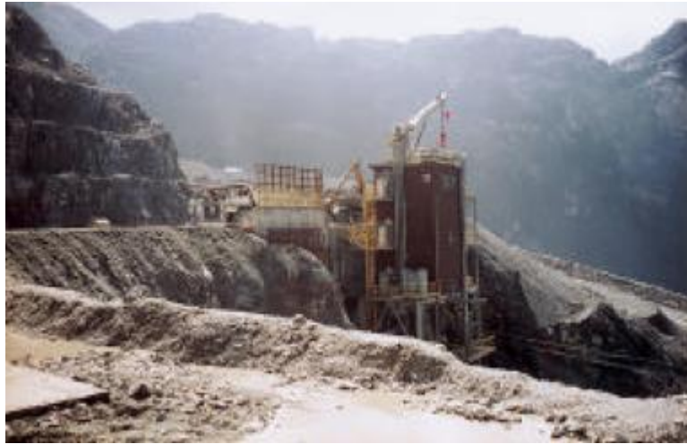
Şekil 4.3. 5 No.lu Yarı mobil kırıcı tesisi.
