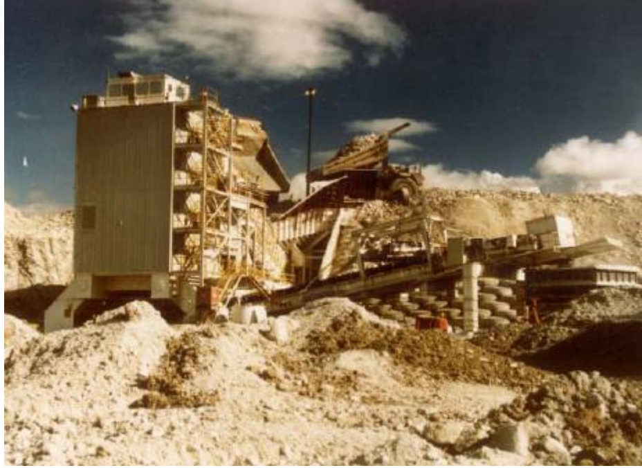
Şekil 4.22 Yarı mobil kırıcı tesisi.
