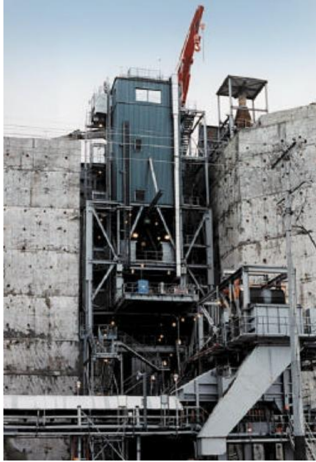
Şekil 4.2 8 No.lu Yarı mobil kırıcı tesisi.
