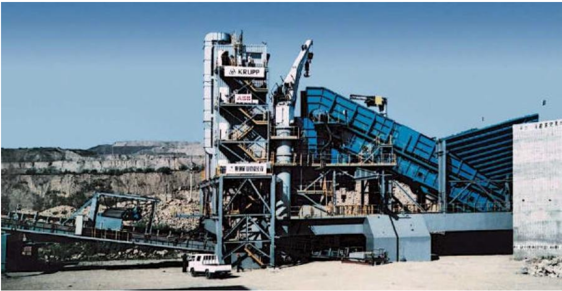
Şekil 4.15 Yarı mobil kırıcı tesisi.
