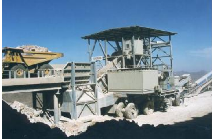
Şekil 4.20 Mobil kırıcı tesisi (Bishah).
