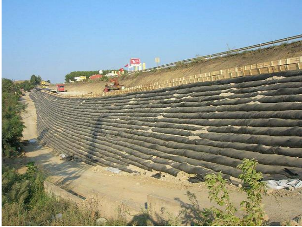
Şekil 4.7 : Dik dolgu şevlerinde geotekstil kullanımı.
