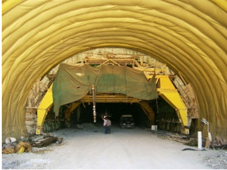
řekil 2.13 : Tnellerde geomembran uygulaması.
