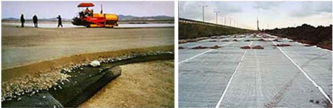
Şekil 2.7 : Kaplamalı yollarda geogrid uygulaması (Polyfabrics Australia).
