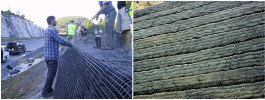
Şekil 2.10 : Şevlerde geogrid uygulaması örnekleri.
