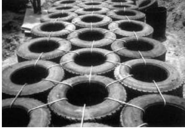
Şekil 3.7 Kamyon lastiklerinin bariyer olarak kullanılması [De et al, 2004]
