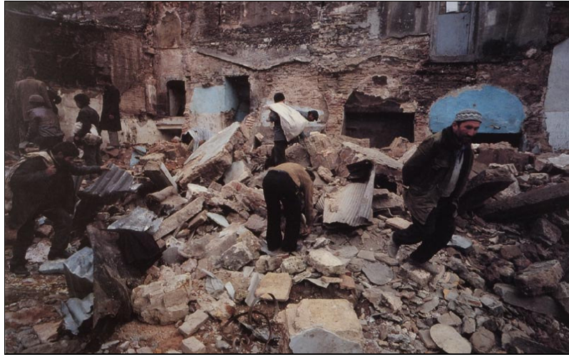
Fotoğraf 40 Eminönü yıkımlarında yıkımdan hemen sonra tahta ve demir parçaları toplamaya gelen çapulcular, Eminönü, 1986
