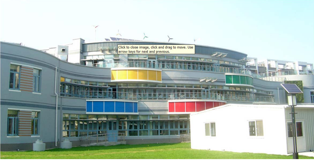
Şekil 3.7 Beijing Olimpiyat Köyü merkez binası BEPV/T sistem çatı uygulaması.
