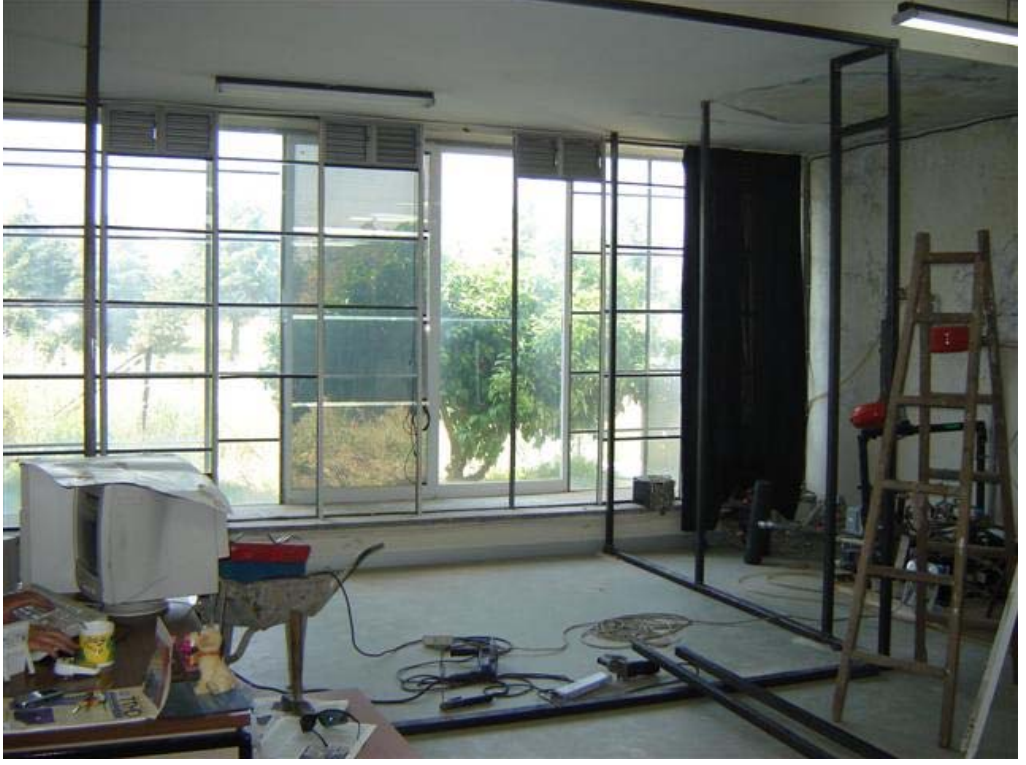
Şekil 4.5 Test odasının demir profiller ile strüktürünün tamamlanması.
