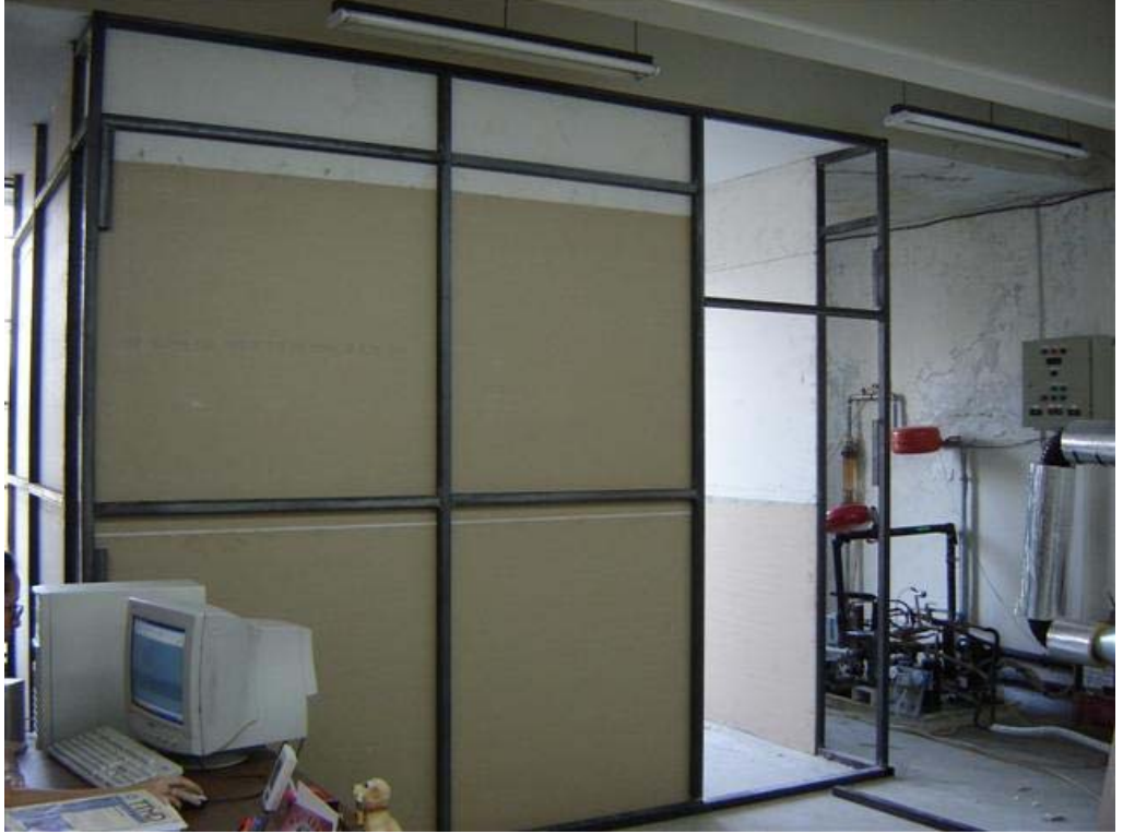
Şekil 4.6 Alçıpan plakaların profillere vidalanarak çerçevenin tamamlanması.
