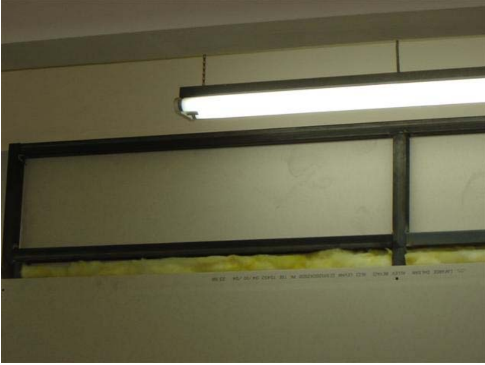
Şekil 4.7 Alçıpan plakaların arasının camyünü ile yalıtılması.
