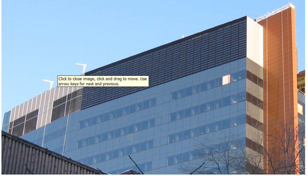
Şekil 3.8 Montreal Kanada’da John Molson School of Business binası BEPV/T sistem cephe uygulaması.
