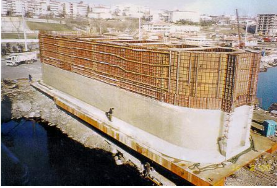
Şekil 2.11 : Keson yapı imalatından bir görünüm.
