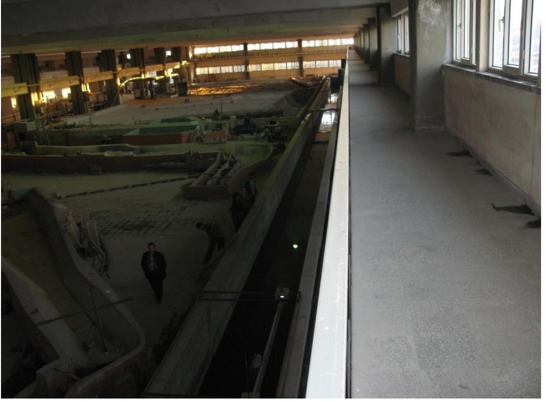
Şekil 3.5 : İ.T.Ü. Hidrolik Laboratuvarı Tsunami Kanalı
