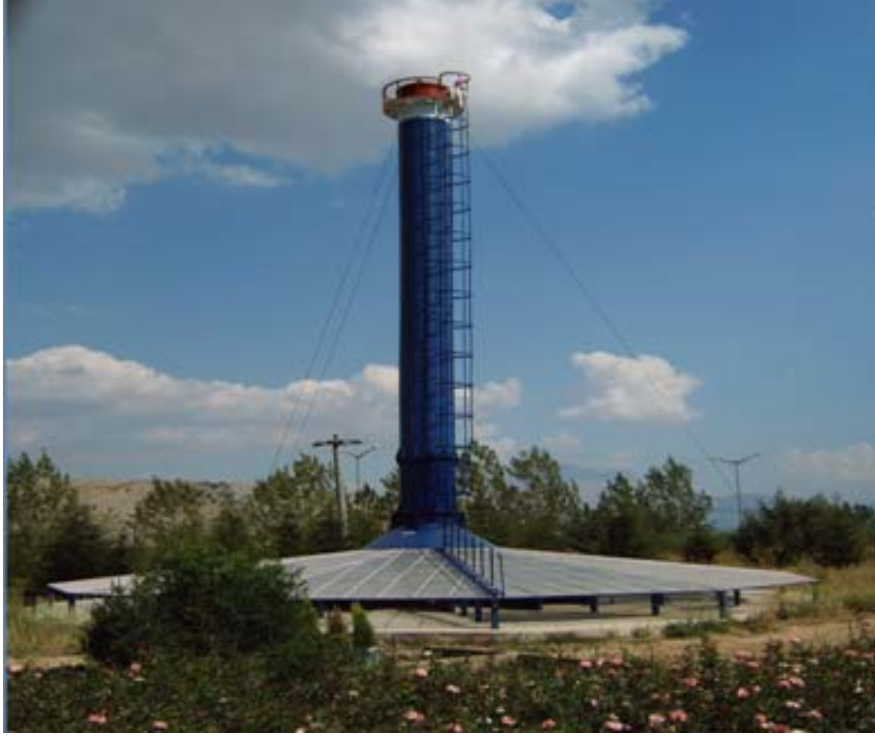
Şekil 2.1. Isparta Üniversitesi'nde kurulan güneş bacası
