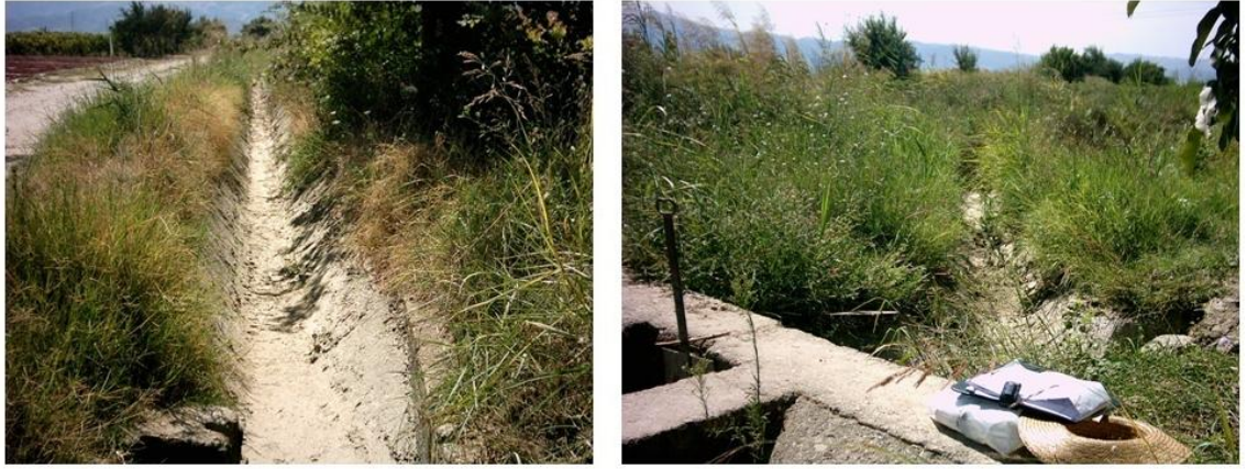
Şekil 4.10 Mülga KHGM tarafından inşa edilmiş olan beton kaplamalı kuvarter kanal görüntüsü (Eylül 2004)
