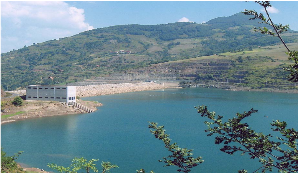
Şekil 3.3 Yuvacık Barajı' nın görüntüsü
