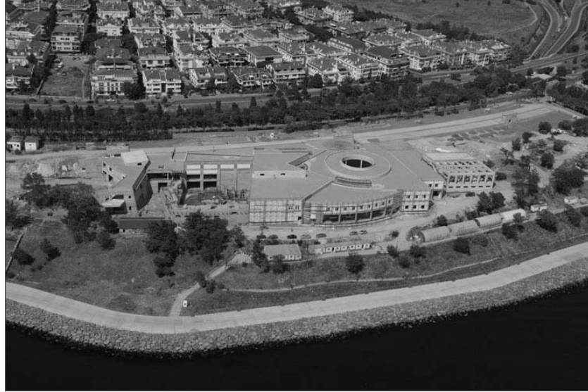
Şekil 4.41 : İstanbul Akvaryumu inşaatı, Florya (Url-10)
