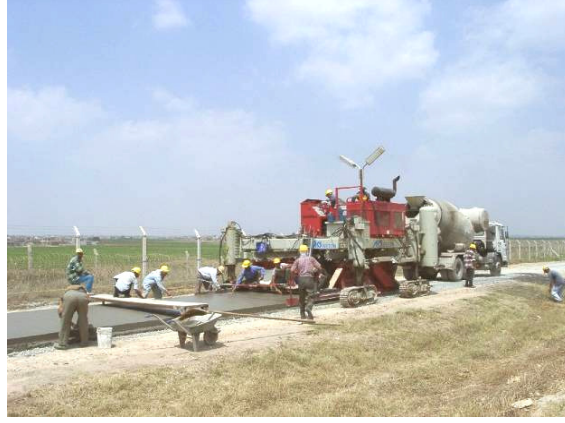
Şekil 4.7 : Adana- İncirlik Hava Üssü çevre güvenlik yolu beton dökümü. [7]
