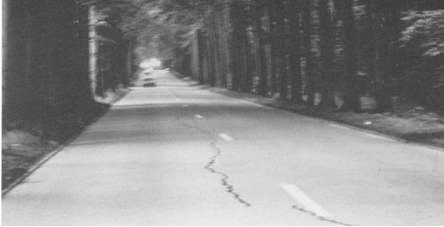
Şekil 4.2 : Dreve-de-Lorraine Karayolu, Brussels; 1925 yılında boyuna derz olmadan inşa edilmiş olan derzli rijit üstyapı. [4]
