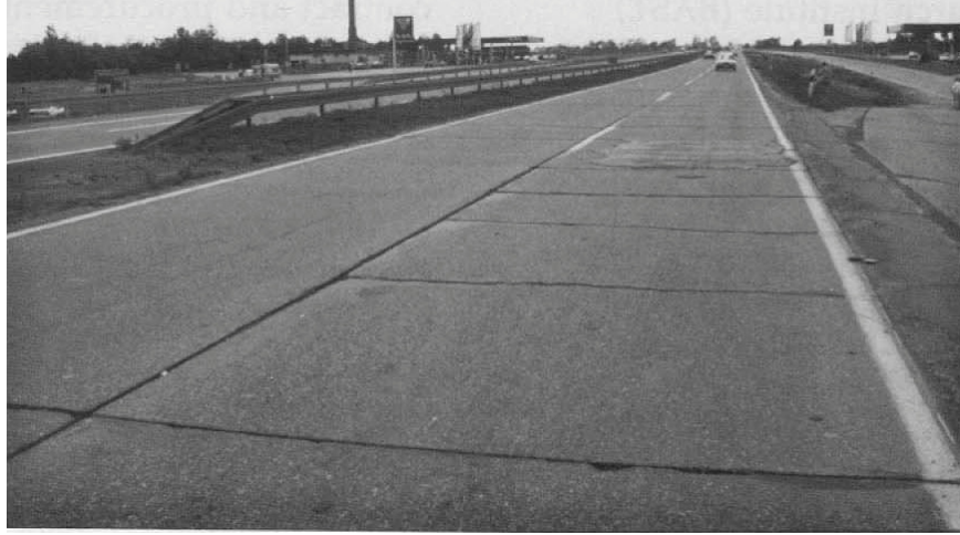
Şekil 4.1 : Berlin yakınlarında 1930’lu yıllarda inşa edilen Alman otoyol rijit üstyapısı. [4]
