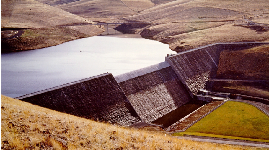
Şekil 7.1 : Willow Creek Barajı. [13]
