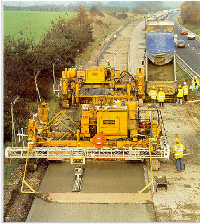
Şekil 2.2 : Kayar kalıp sistemi ile rijit üstyapı uygulaması [8]
