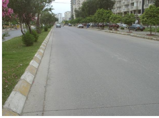
Şekil 4.4 : Adana-Turgut Özal Bulvarı (Yapım yılı: 1986-1987, 2x3 şerit) [7]
