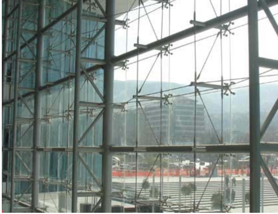
Şekil 2.4 : Noktasal taşıyıcılı giydirme cepheler (Spider)
