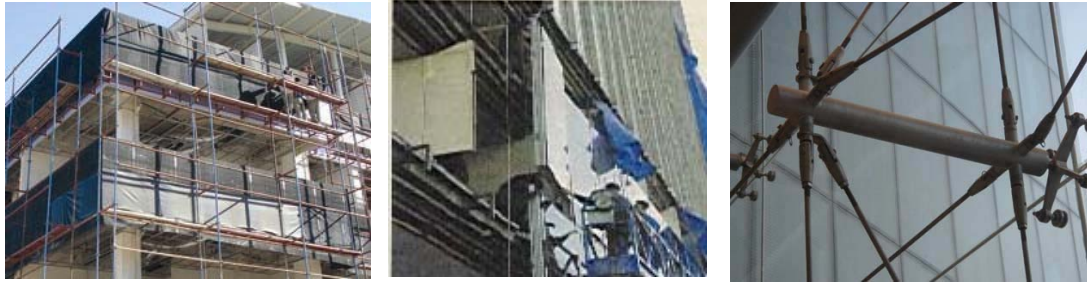
Şekil 2.1 : Cephenin taşıyıcı sistemle bağlantısı
