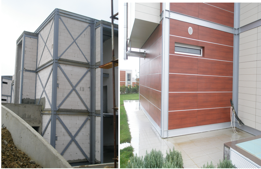
Şekil 4.6 : Cephe duvarları uygulaması
