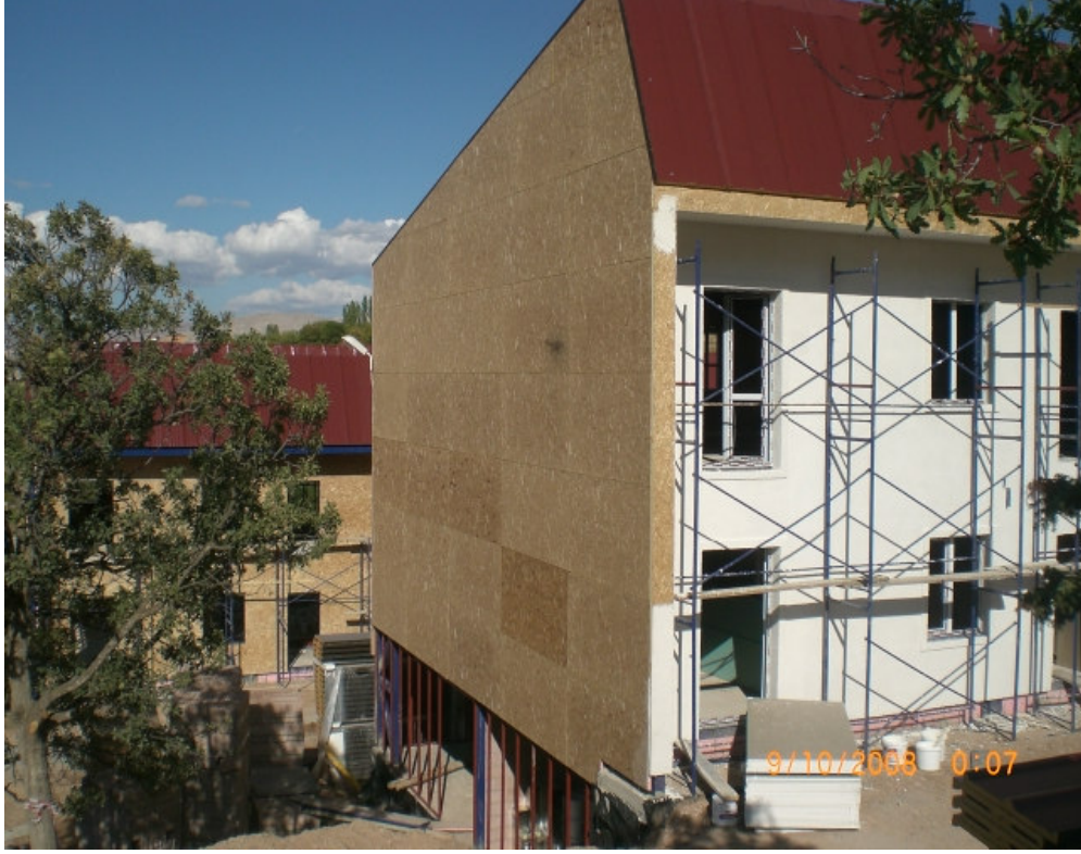
Şekil 4.13 : Cephe duvarları uygulaması
