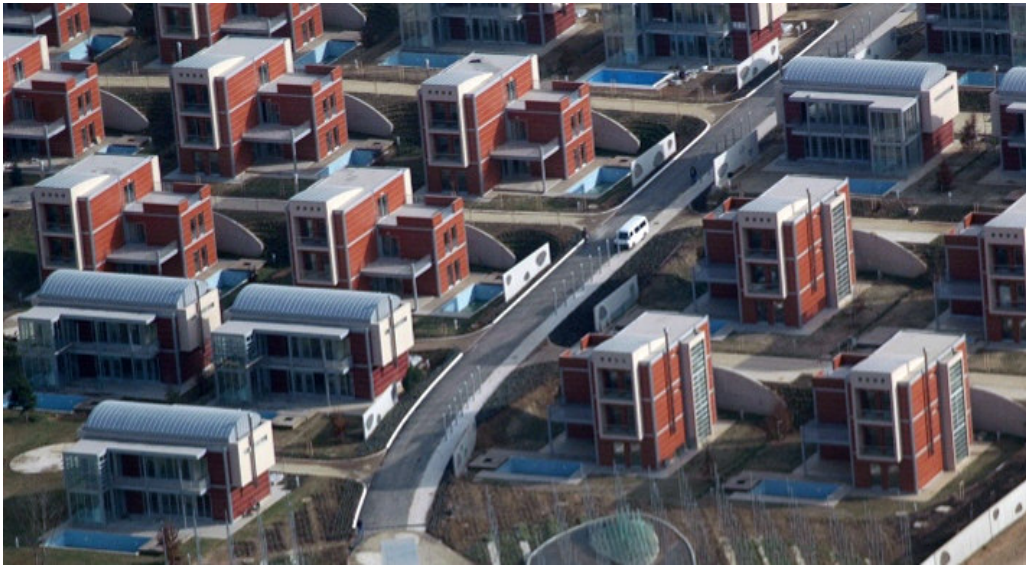
Şekil 4.2 : Millenium Park Evleri genel görünüş
