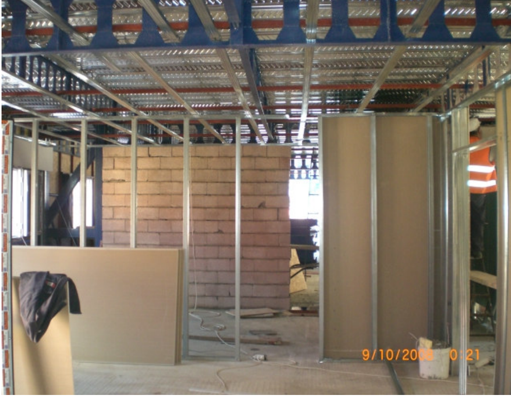
Şekil 4.14 : İç duvar uygulamaları
