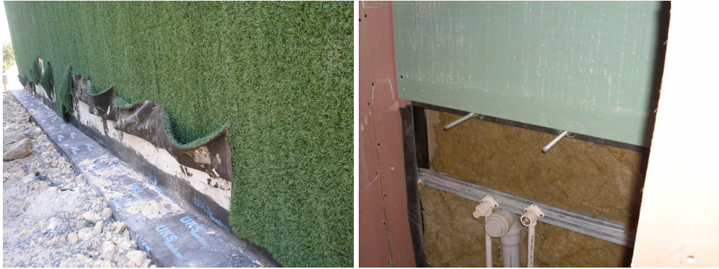
Şekil 4.22 : Dış ve İç duvar uygulamaları
