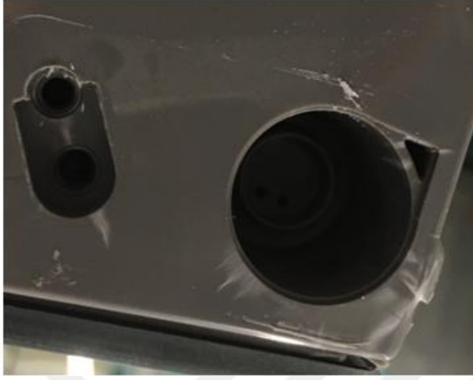
Şekil 2.8 : Kapı alt kapama parçasındaki deformasyon.
