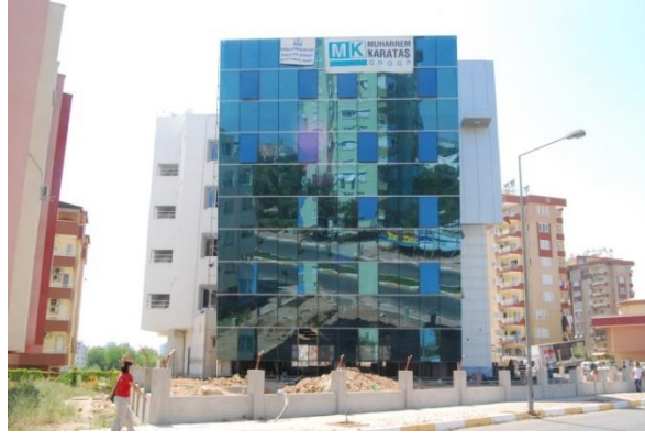
Şekil 3.2. Antalya Makine Mühendisleri Odası Binası- Doğu Cephesi
