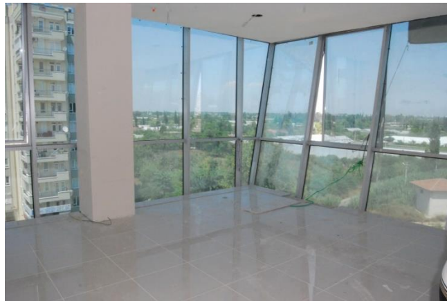
Şekil 3.4. Antalya Makine Mühendisleri Odası Binası giydirme cephe sistemi
