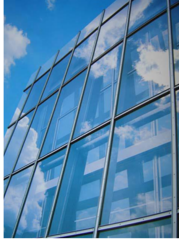
Şekil 2.20. Yatay ve düşey akslarda çelik görümlü kapak uygulaması (Cephesistemleri, 2016)
