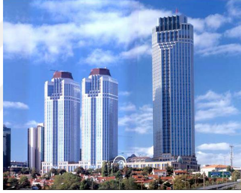
Şekil 2.14. İş Bankası Genel Müdürlük Binası (Arkiv, 2018)
