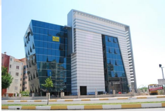
Şekil 3.1. Antalya Makine Mühendisleri Odası Binası- Kuzey Cephesi
