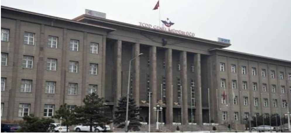
Şekil 24. TCDD Genel Müdürlüğü Binası
