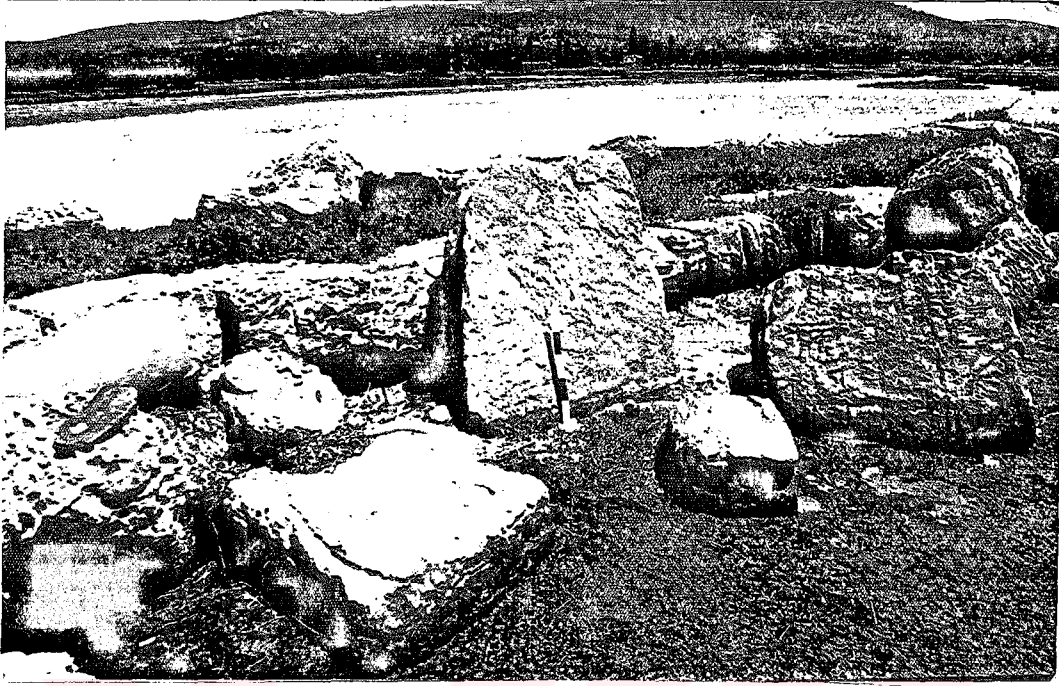
Levha 3a Ana mendirek M1 boyunca tahrip edilmiş üst blok taşlar.
