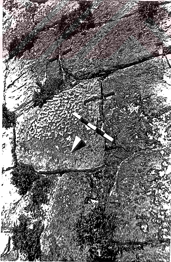
Levha 12b Ana mendirek üzerinde kırlangıç kuyruğu şeklinde kenetlerle tutturulmuş blok taşlar.
