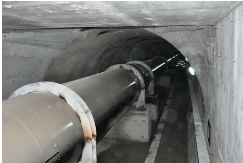
Şekil 3.5. Kondüvi ve cebri boru görünüşü.
