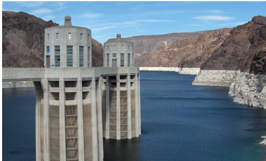
Şekil 3.3. Hoover Barajı su alma kuleleri (USA).
