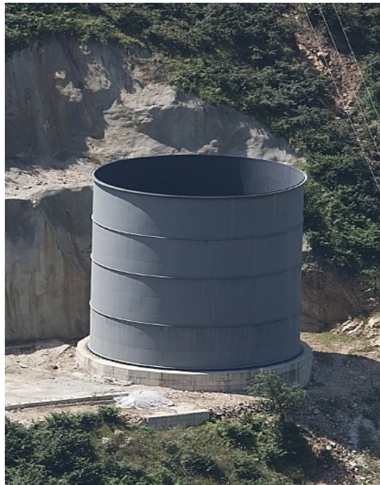
Şekil 3.9. Dairesel kesitli denge bacası.
