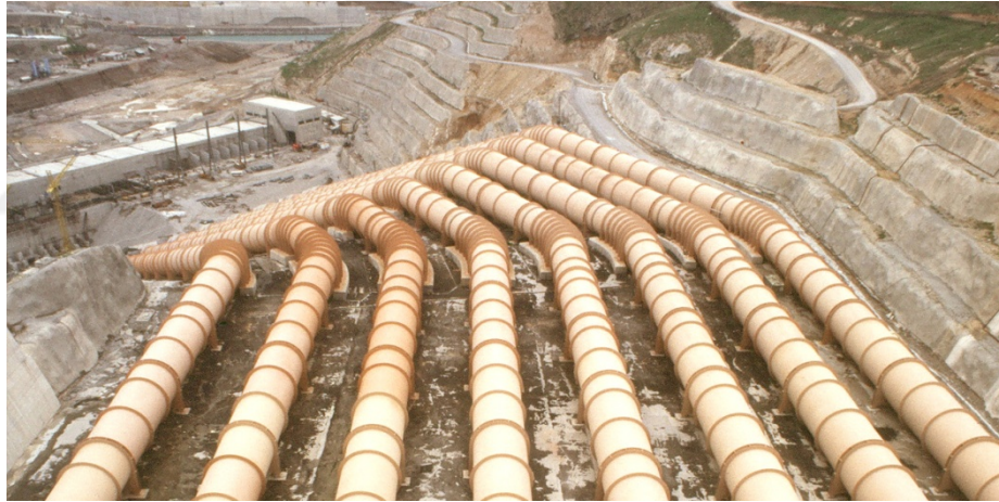
Şekil 3.11. Atatürk Barajı türbinlerini besleyen cebri borular.
