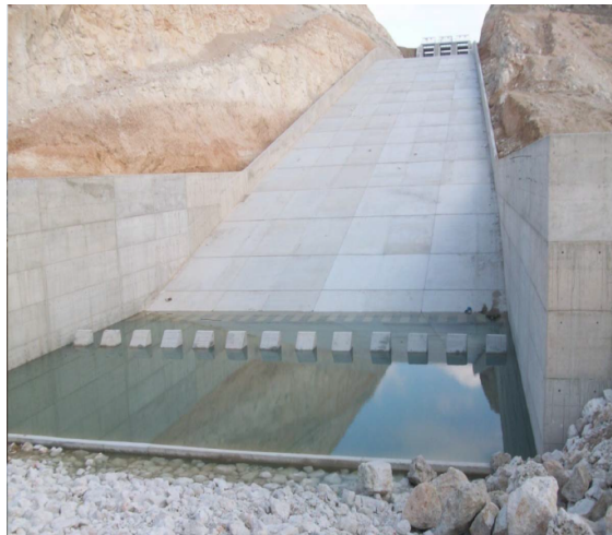
Şekil 3.8. Boşaltım kanalı ve enerji kırıcı havuz.
