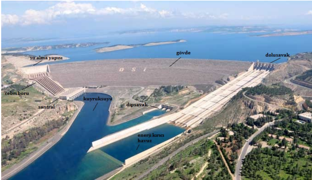
Şekil 3.1. Atatürk Barajı üzerindeki HES elemanlarının gösterimi.
