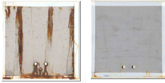
Şekil 3. 23 Kesilen panellerin kenarlarının yanlış ve doğru bantlanması sonucu paslanma durumu [88]
