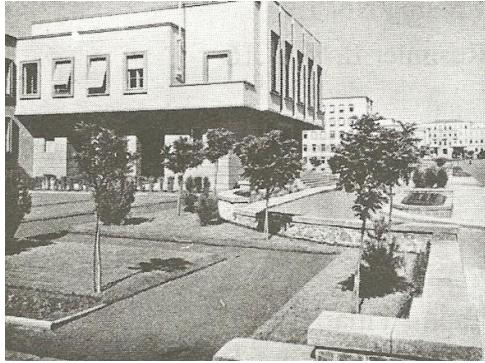
Resim 4.43. Bayındırlık ve İskan Bakanlığı Binası (Holzmeister, 1934) (Aslanoğlu, 2010)
