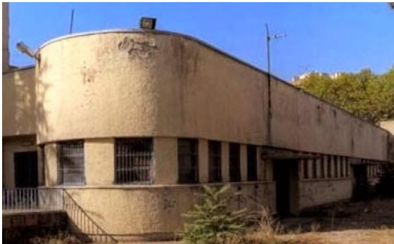
Resim 5.25. Su Süzgeci Binası (arkitera.com)
