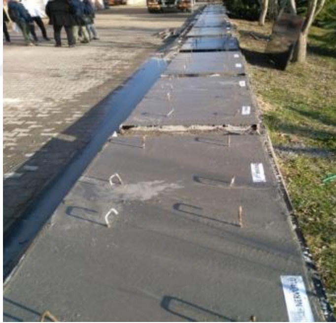
Şekil 4.25. Beton dökme işleminin tamamlanması ve isimlendirilmesi
