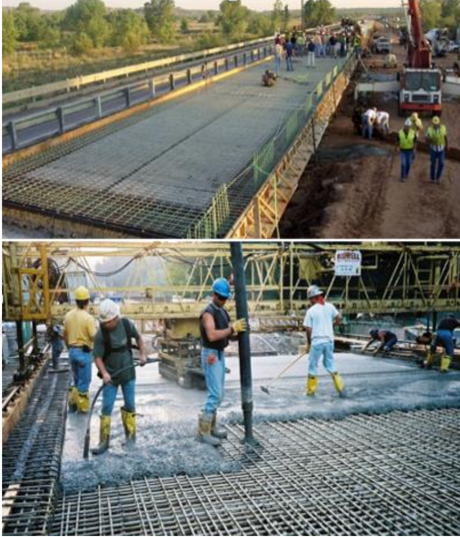
Şekil 3.14. FRP donatıların köprü döşemelerinde kullanımı [1].
