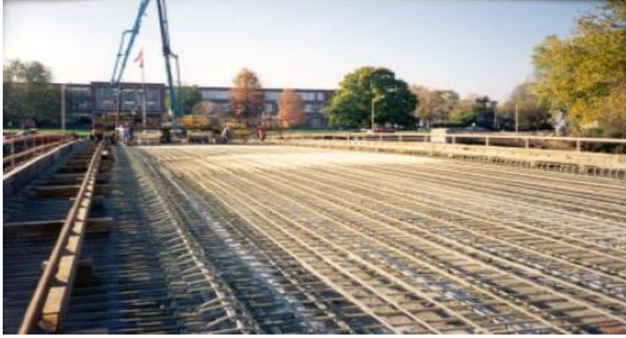
Şekil 3.11. Ohio'da köprü döşemesinde GFRP donatılar [1].
