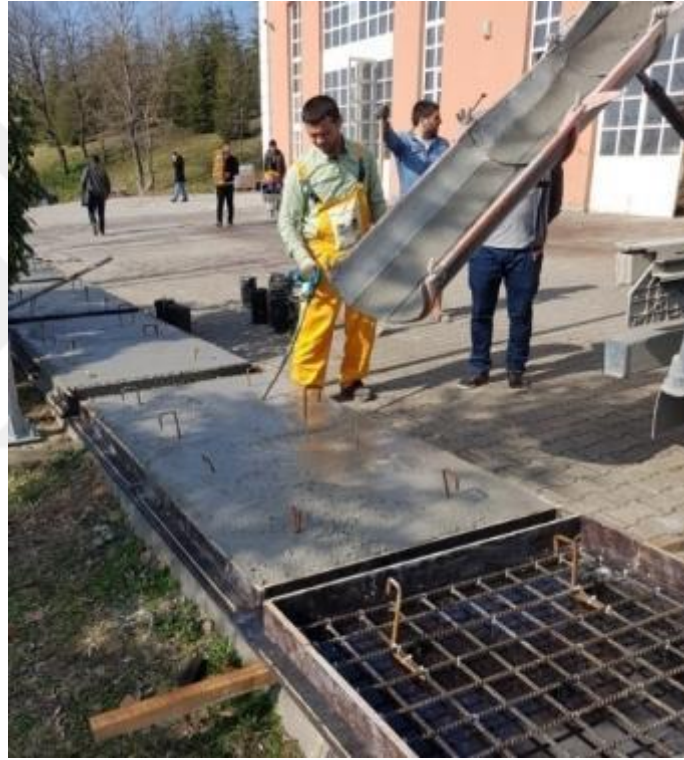
Şekil 4.23. Beton döküm işlemi
