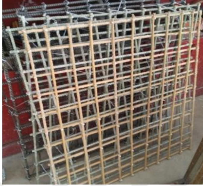
Şekil 4.17. FRP Donatı çubuklarının hazırlanması ve montaj aşaması
