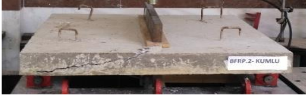
Şekil 4.68. BFRPK donatılı döşeme kırılma sonrası
