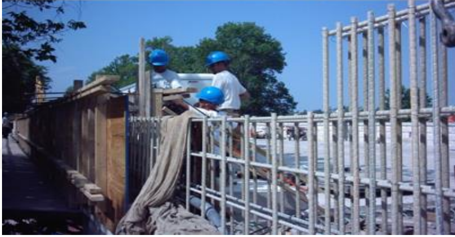
Şekil 3.15. FRP donatıların kıyı yapılarında kullanımı [1].
