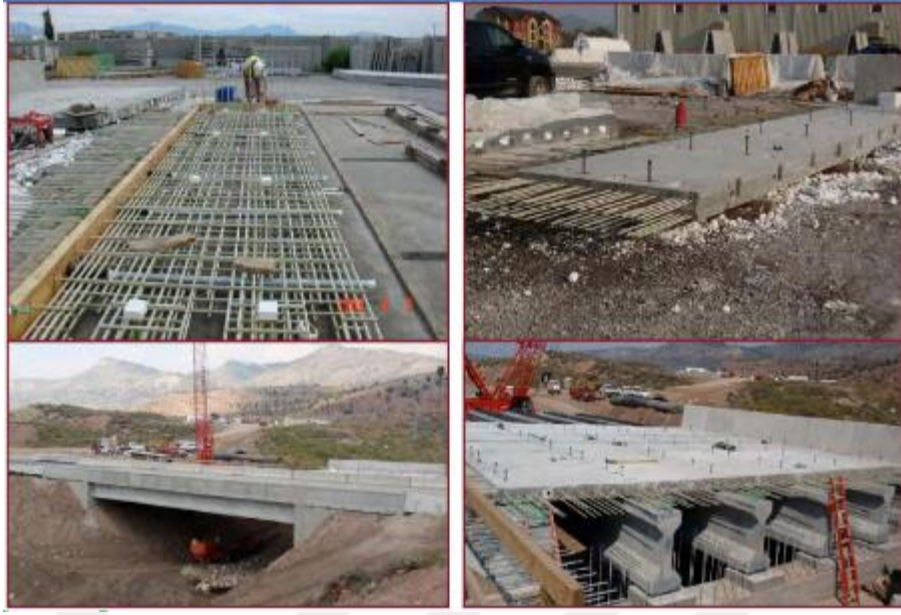
Şekil 3.13. Emma Park Köprüsünde GFRP Kullanımı [1].
