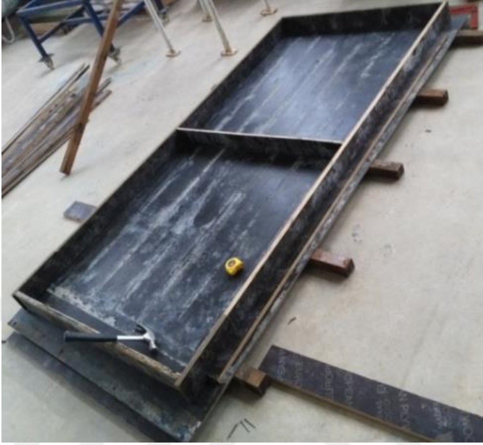
Şekil 4.16. Kalıp sisteminin hazırlanması
