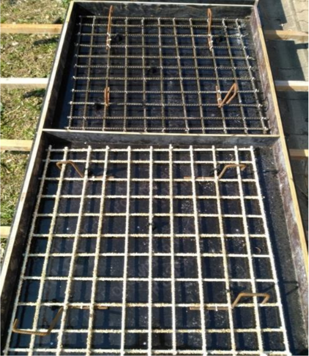
Şekil 4.20. FRP donatıların kalıplara yerleştirilmesi
