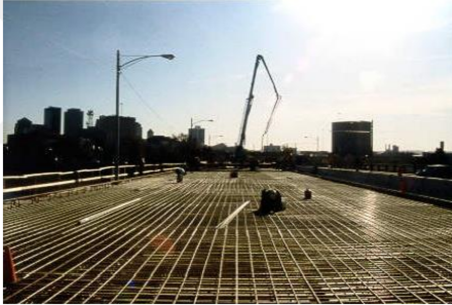
Şekil 3.12. Salem Avenue Köprüsünde GFRP kullanımı [1].
