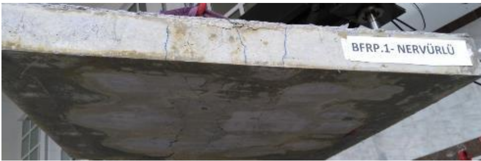
Şekil 4.71. BFRPN donatılı döşeme kırılma detayı
