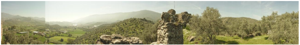
Şekil 3.17 Miletos mermer ocaklarından Herakelia mermer ocaklarına bakış (Orijinal 2017)
