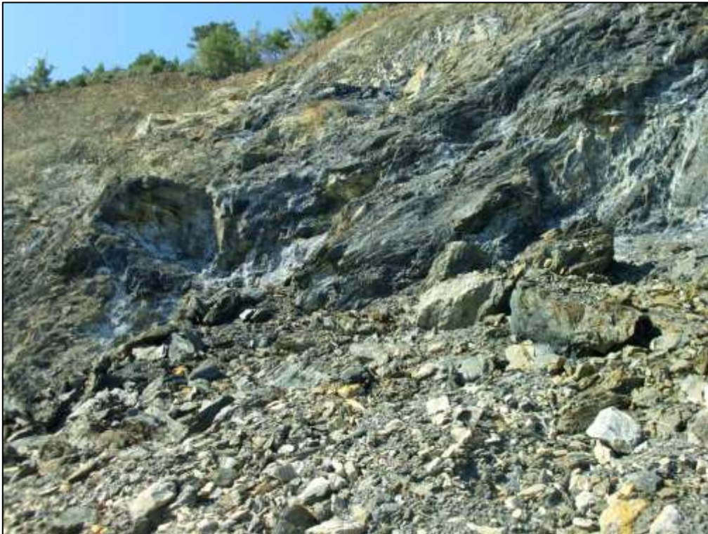
Şekil 5.2. Çalışma alanındaki şevde gözlenen bozunma ve dökülmeler.
