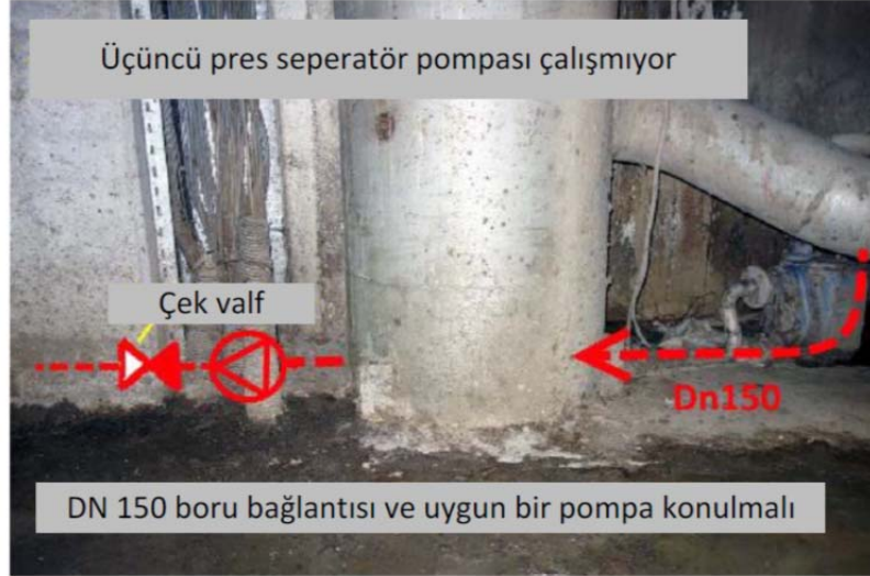
Şekil 6. 31 Vakum seperatörü dizayn hatası
