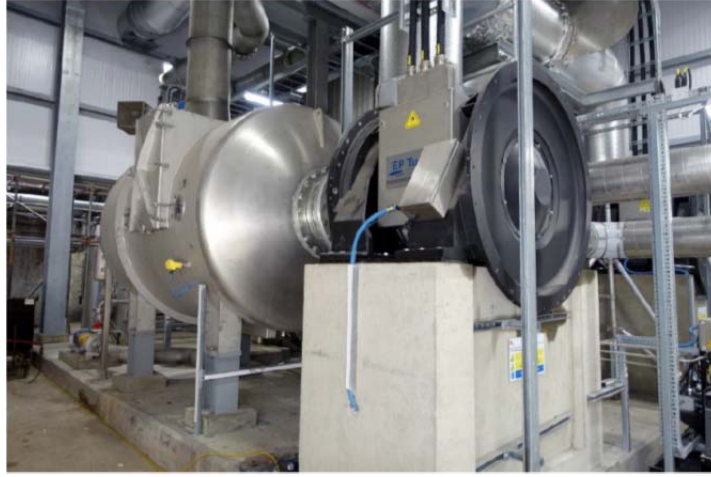
Şekil 6. 37 Turbo blower
