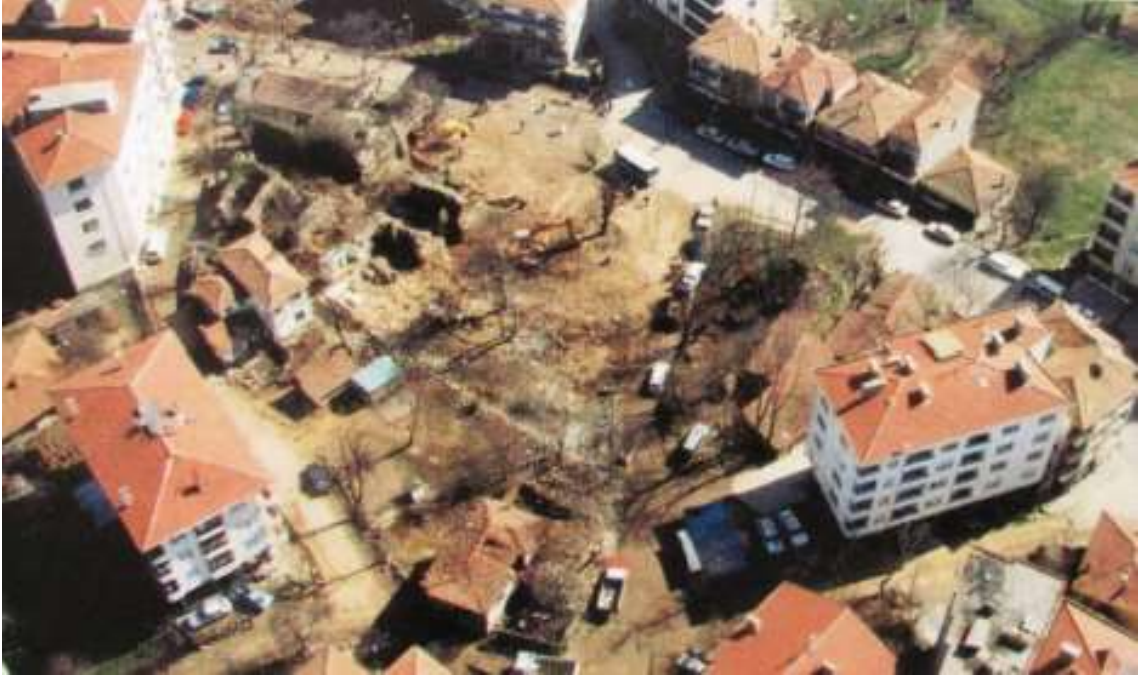
Şekil 1.3: Damatrys Sarayı çevrede bulunan yapılar (Uçar,2008).
