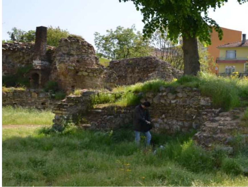
Şekil 3.6: Damatrys Sarayı kayalarda meydana gelen deformasyonların tanımlanmasına ait görüntü.
