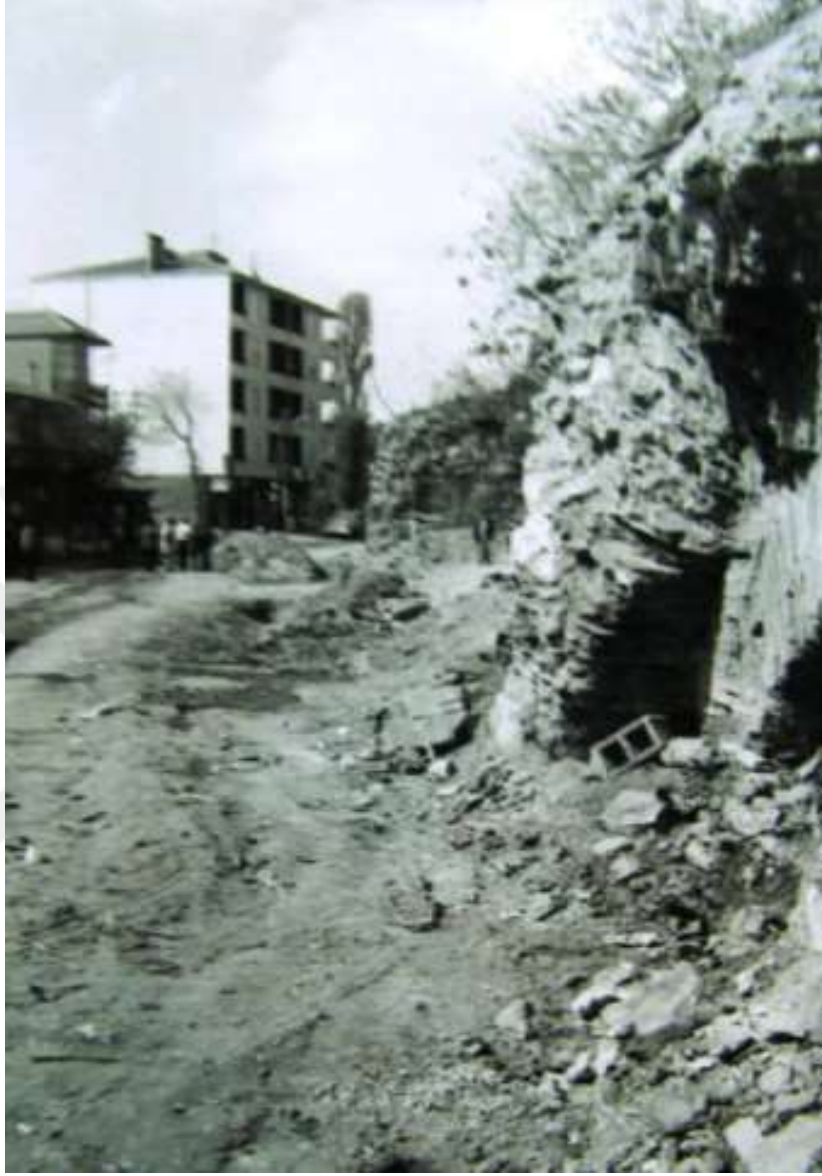
Şekil 1.4: 1993 yılında yapılan yol altyapı çalışmaları (İstanbul Bölge Kurulu Arşivi).
