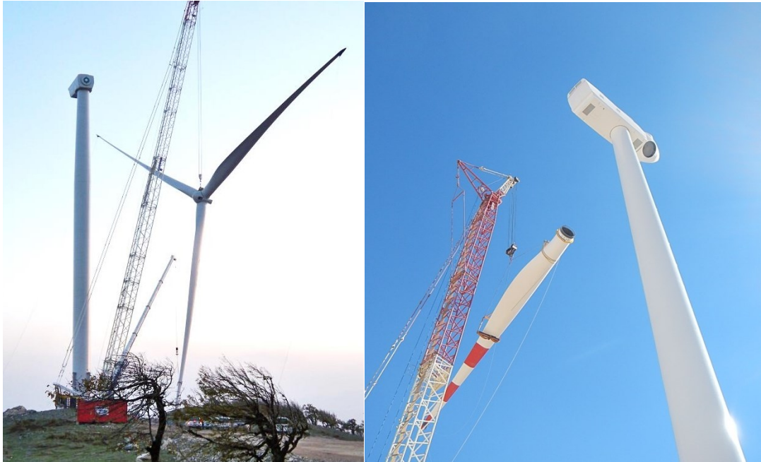
Şekil 5.3 : Fotoğraf; rotorun yerde montajı ve kule tepesinde montajı.
