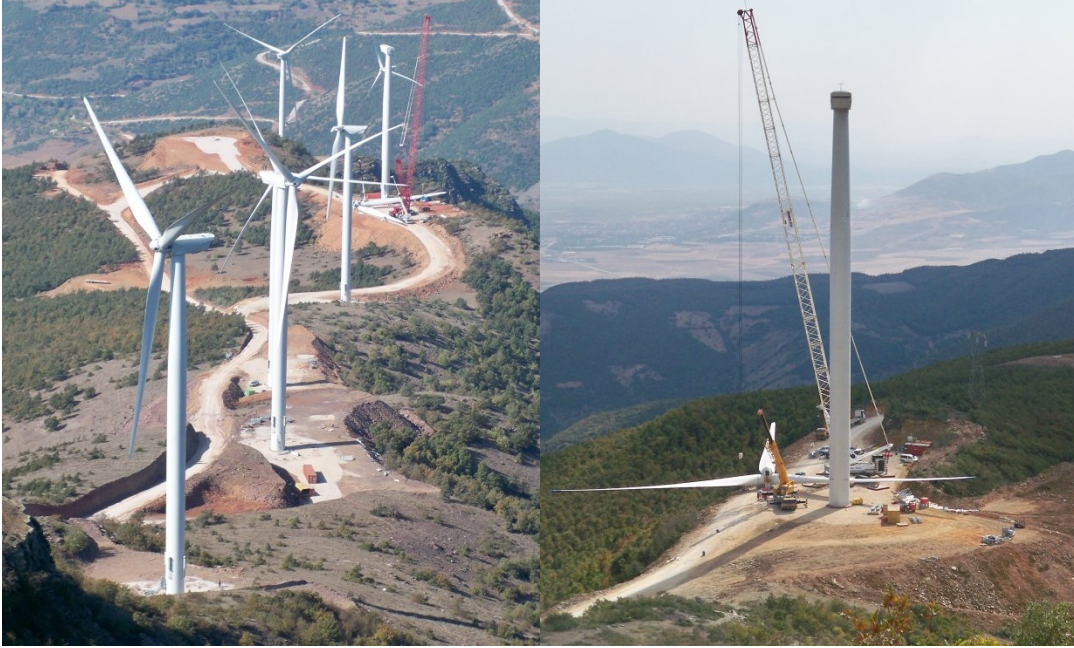
Şekil 4.8 : Fotoğraf; platform, yol ve rotor için değişime uğrayan alanlar.
