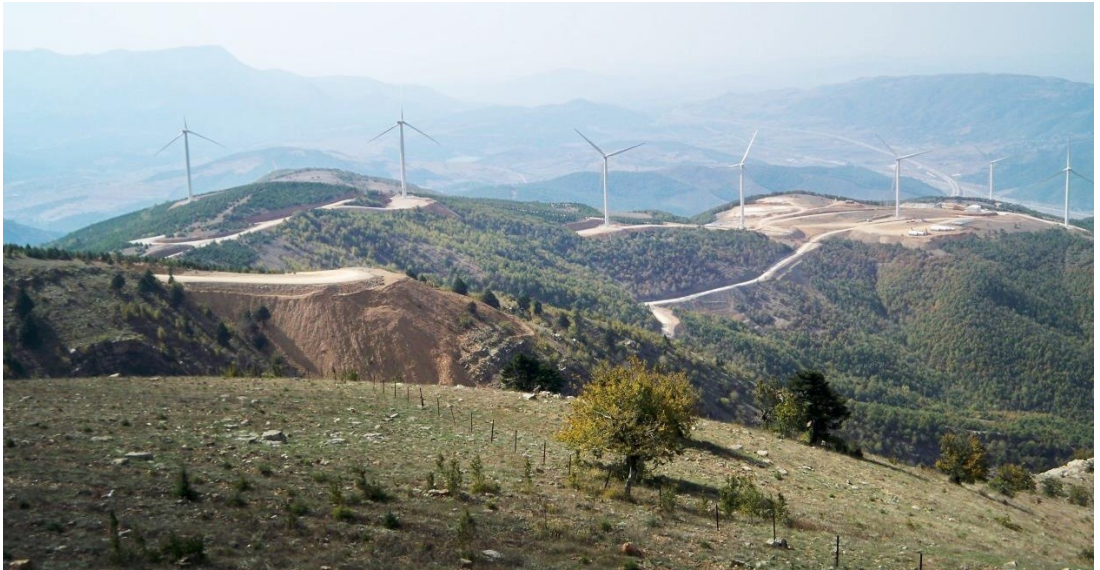
Şekil 4.13 : Fotoğraf; saha içi yol ve dolgu örneği.
