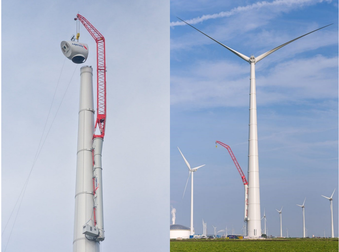
Şekil 5.4 : Kule ile birlikte yükselabilen vinç örneği, yeni uygulama [27].
