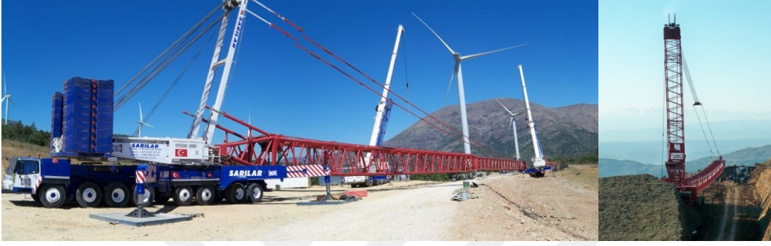
Şekil 4.11 : Fotoğraf; yerde vinç kurulumu örnekleri.
