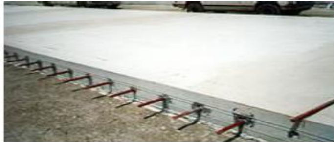
Şekil 2.13. Beton yolda bağlantı demirleri (Pancar, 2012)
