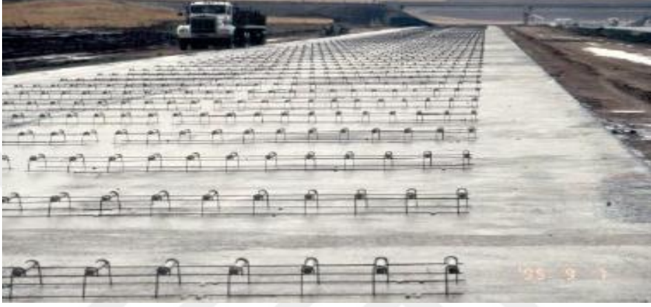
Şekil 2.12. Kayma demir uygulaması gösterimi (Pancar, 2012)
