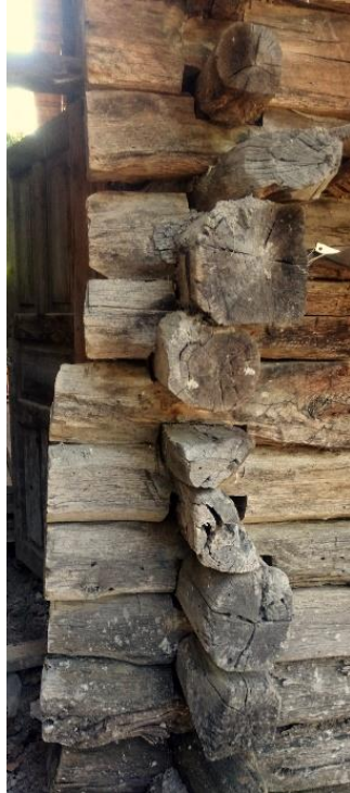
a) Zemin katta karaboğaz geçme. b) Birinci katta kurtboğazı geçme.
