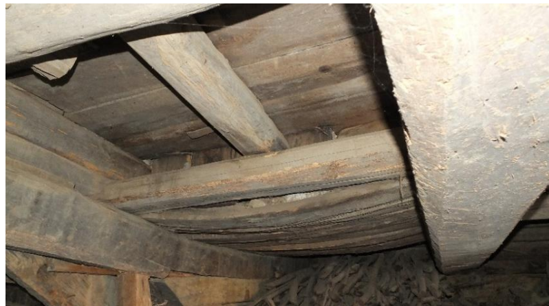
Şekil 3.109. Üst kattaki ocağı taşıyan hamal ağaçları.
