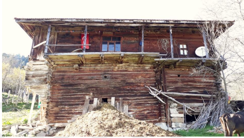
a) Cephe fotoğrafı / Abdullah Bey evi kuzeydoğu cephesi.
