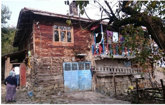
a) Güneybatı cephesi
