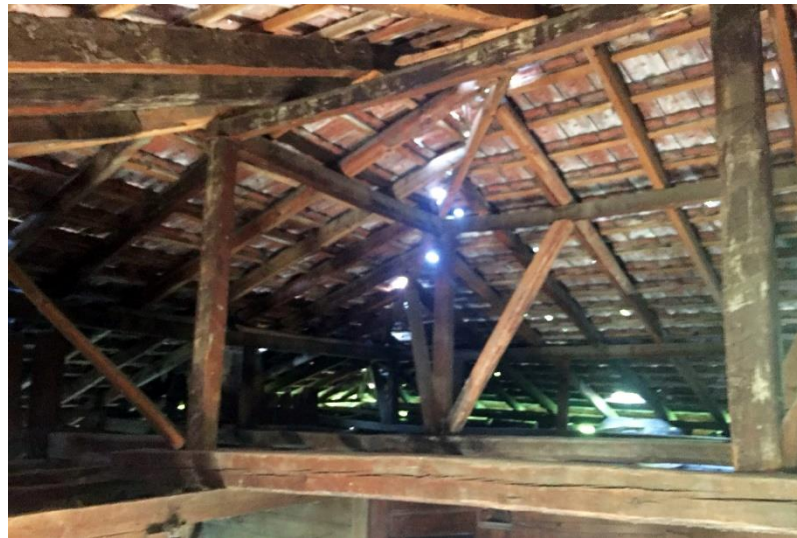
c) Topal Kâhya konağı çatısı.
