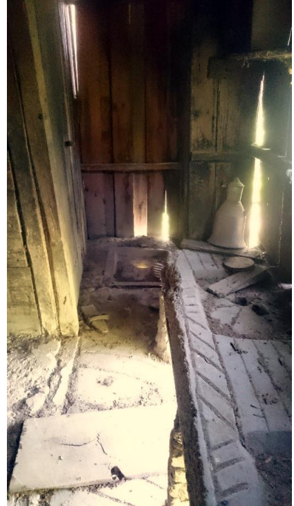
b) Topal Kâhya konağı abdestlik ve abdestliğin iki yanında bulunan hellardan bir tanesi. Zemin, hela ve abdestlik tahtası yapılan bir tadilat esnasında mozaik ile onarılmış.
