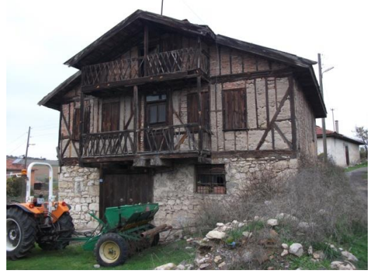
b) Ahşap iskelet sistemli ev (Akören köyü / Karabük).
