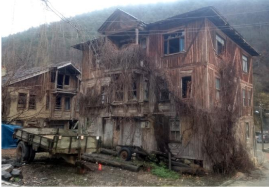
a) Ahşap dolgulu ahşap karkas ev (Ilıca köyü / Mudurnu / Bolu).
