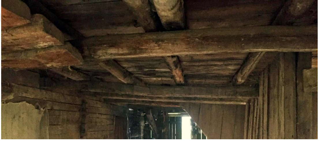
Şekil 3.108. Zemin kat tavan döşemesi / Topal Kâhya konağı.
