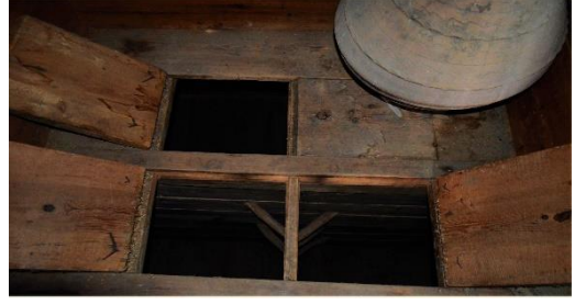
d) Alt kata açılan kapaklar ve merdiven.
