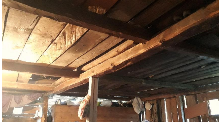
a) Abdullah Bey evi çardak tavanı ahşap döşeme ile kapatılmıştır.
