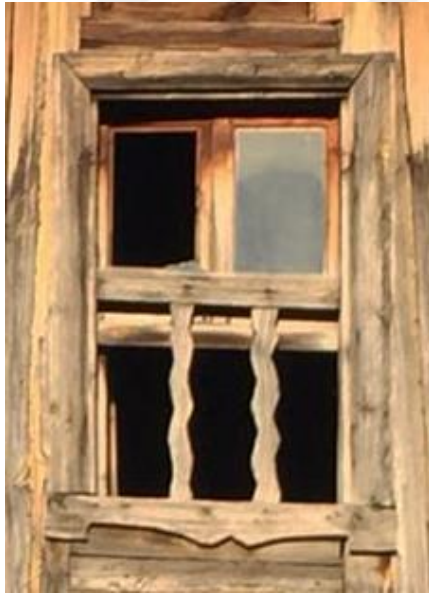
c) Topal Kâhya konağı penceresi, dışarıdan.
