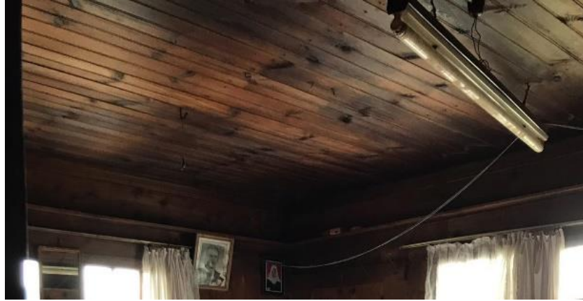
b) Mesut Bey evi odasında kirişler altına tahta çakılarak kapatılmış.
