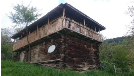
e) Ahşap yığma (Akkışla köyü)
