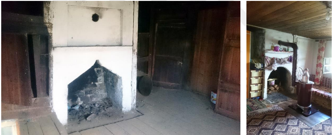
a) Topal Kahya konağı mutfağı
