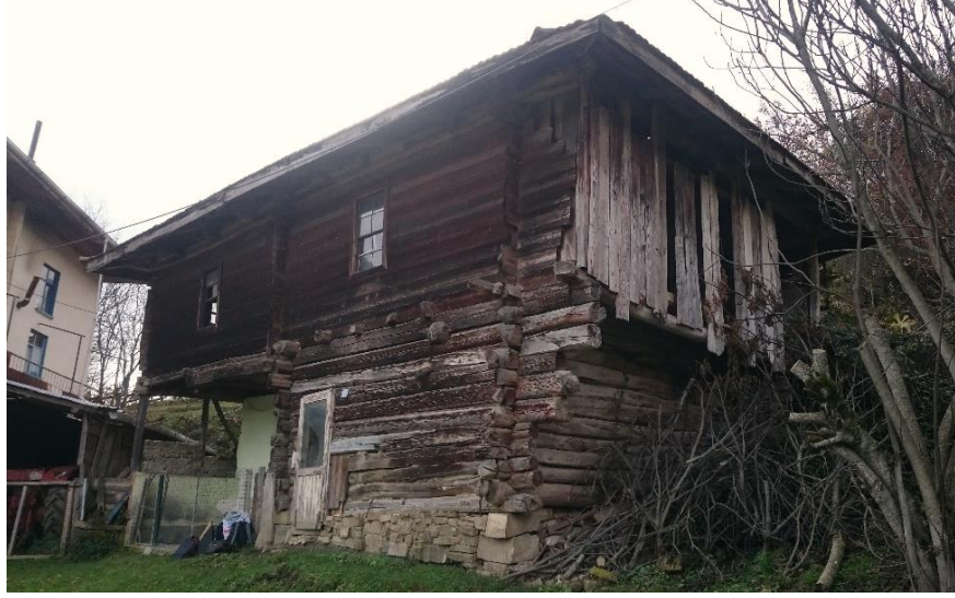
a) Kuzey ve doğu cephesi
