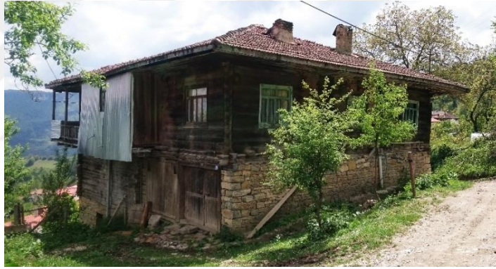
c) Islak hacim cephesi sac ile kaplanmış ev.
