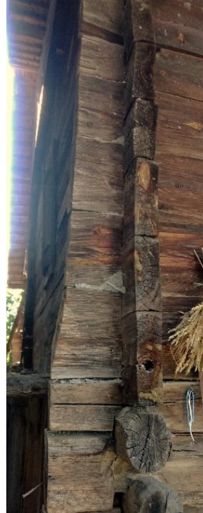
a) Zemin katta karaboğaz geçme. b) Birinci katta kurtboğazı geçme.
