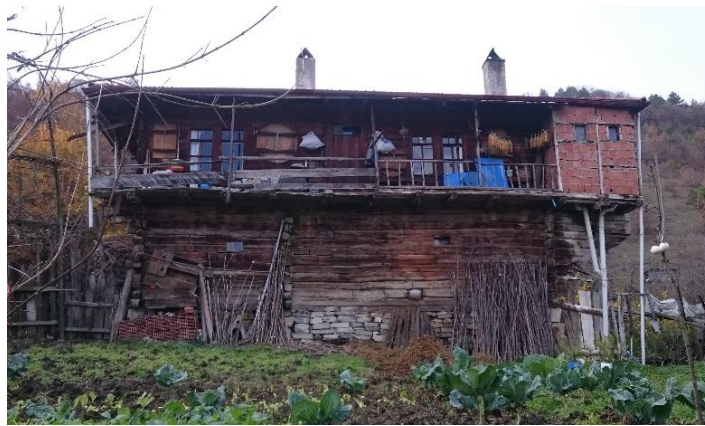
d) Islak hacim cephesindeki tahtalar sökülerek yerine tuğla örülmüş ev.
