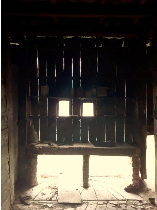
b) Topal Kâhya konağı abdestlik ve abdestliğin iki yanında bulunan hellardan bir tanesi. Zemin, hela ve abdestlik tahtası yapılan bir tadilat esnasında mozaik ile onarılmış.
