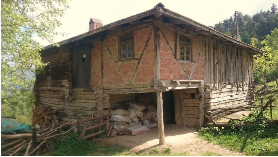
Şekil 3.135. Bütünleştirme işlemi uygulanması gereken bir çantı ev.
