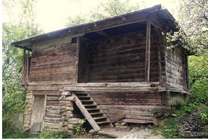
a) Cephe fotoğrafı.
