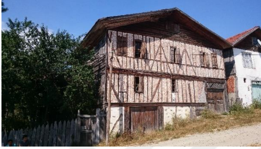
c) Tuğla dolgulu (Saçak köyü-Eflani)
