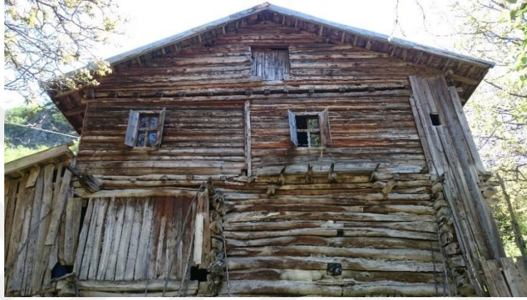
Şekil 3.97. Cephe fotoğrafı / Recep Bey evi kuzey cephesi.
