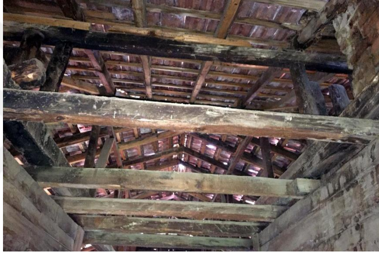
b) Topal Kahya konağı çardak tavanı. Çardağı çatı arasından ayıran döşeme yoktur.
