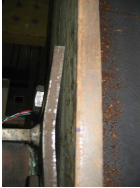
Şekil 2.12. Tahir vd. (2008) birleşim bölgesi deformasyonu
