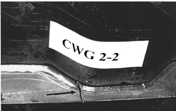
Şekil 2.11. Sherif vd. (2006) yorulma çatlakları
