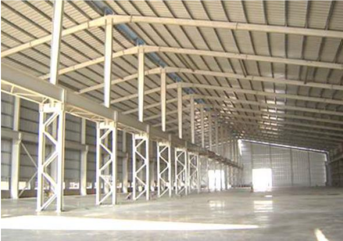
Şekil 1.2 : Endüstri yapılarında yapma enkesitli kolonlarının kullanım örnekleri [2].
