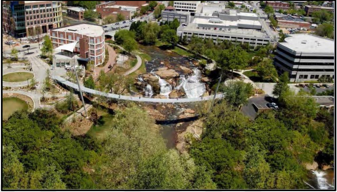
Şekil 58. Liberty Köprüsü-Greenville Güney Carolina (Yenil, Uzun ve Şahin 2015)
