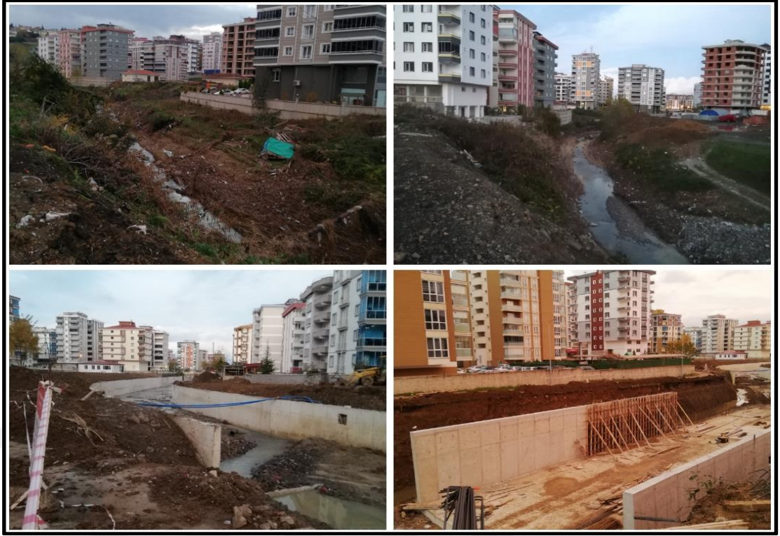
Şekil 48. Afanlı Deresi taşkın yatağı içerisine yapılmış binalar ve derenin ıslah çalışması
