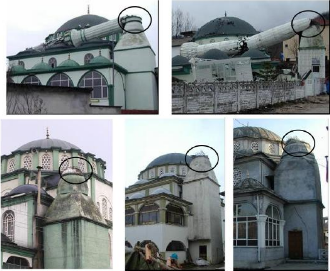
Şekil 1.4 Deprem'den dolayı yıkılmış betonarme minare örnekleri (Sezen, 2008)
