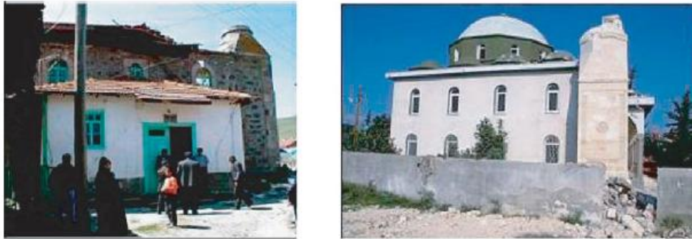
Şekil 1.2 Deprem’den dolayı yıkılmış yığma minare örnekleri. (Doğangün , 2008)
