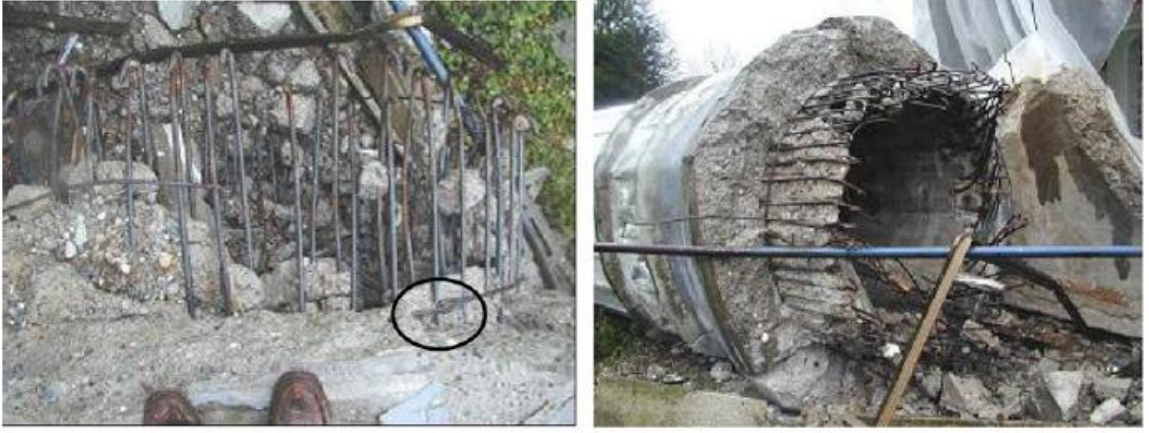
Şekil 1.3 Deprem'den dolayı yıkılmış betonarme minare ve kancasız, geniş aralıklı etriye detayları (Sezen, 2008)
