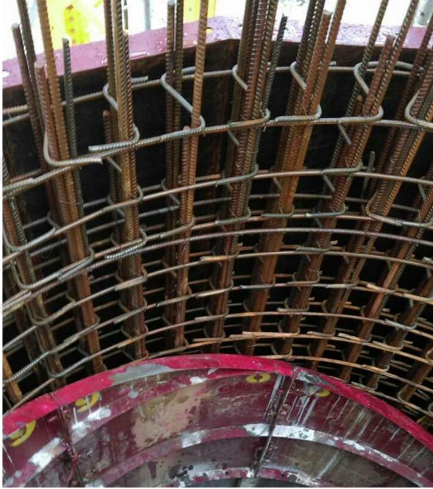
Şekil 3.2 Betonarme bir minarenin donatı dizilim detayları
