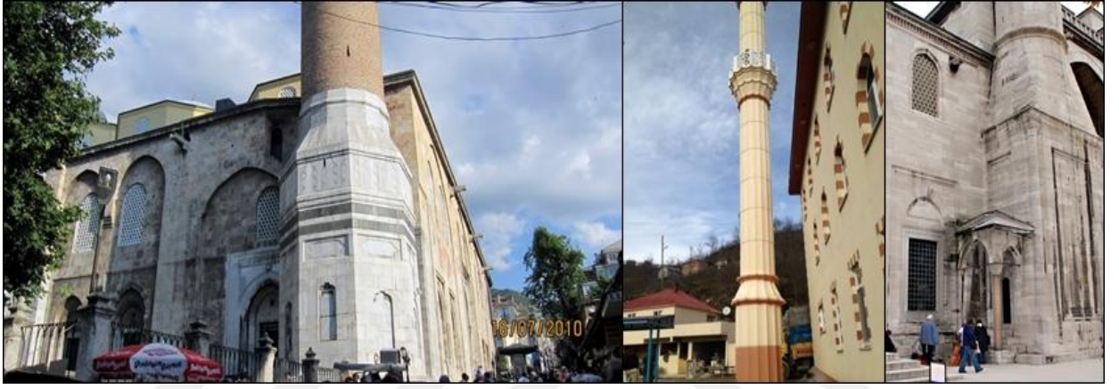
Şekil 1.8 Farklı geometrik şekillere sahip kaide ve küp kısımları
