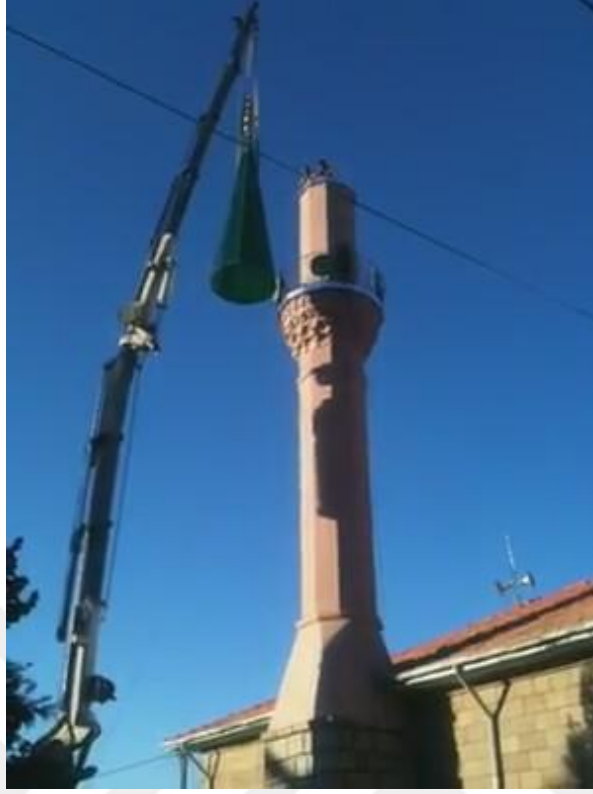
Şekil 1.6 Minare külâhının yerleştirilmesi
