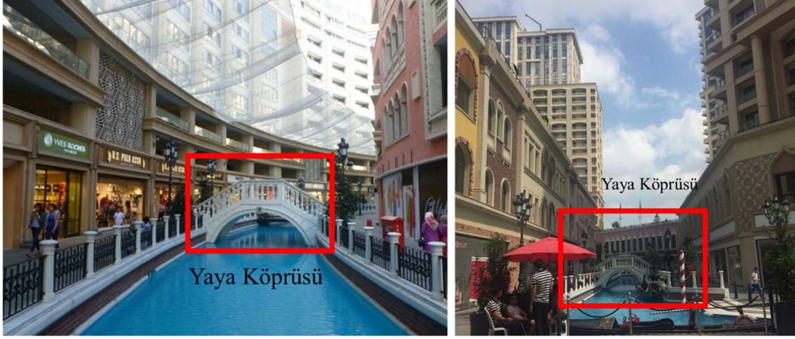
Şekil 3.8 Viaport Venezia Yaya Geçiş Köprüleri.
