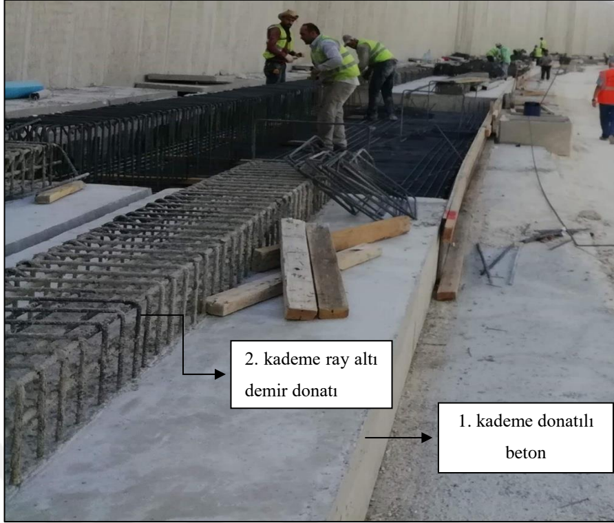
Şekil 2.9. Slab track yapısında 1. ve 2. kademe beton demir donatı uygulaması.
