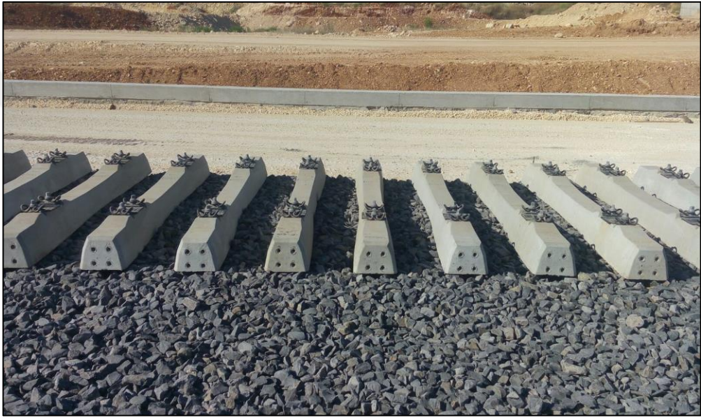
Şekil 1.4. B 70 tipi beton travers.
