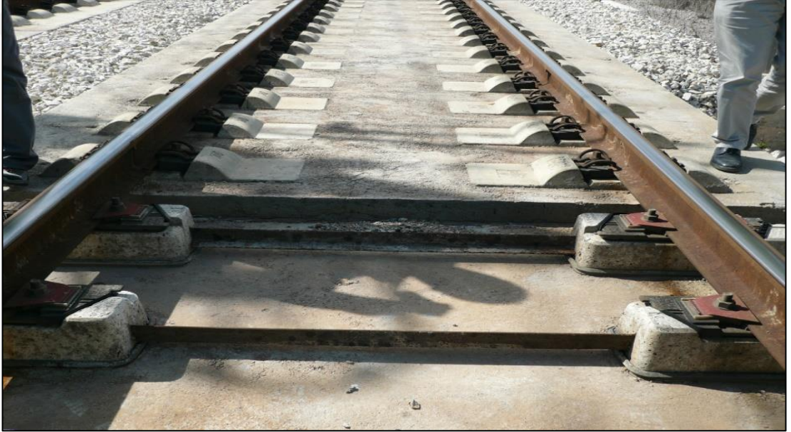
Şekil 1.5. Stedef-Sonneville tipi travers [5].
