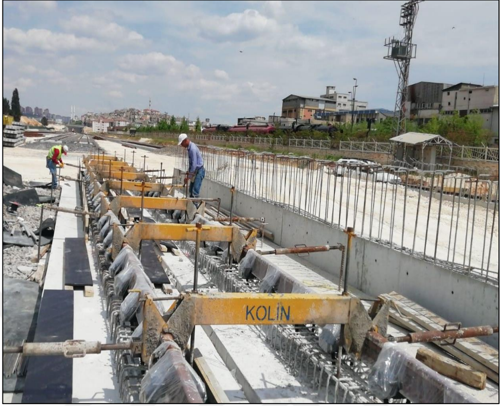
Şekil 2.8. Fikstürleme işlemi.
