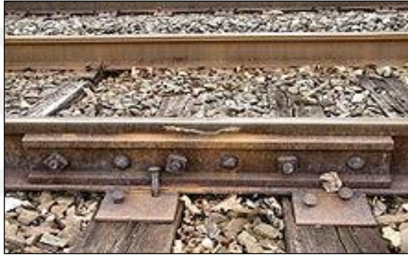
Şekil 1.11. Cebire ile birleştirilmiş raylar.
