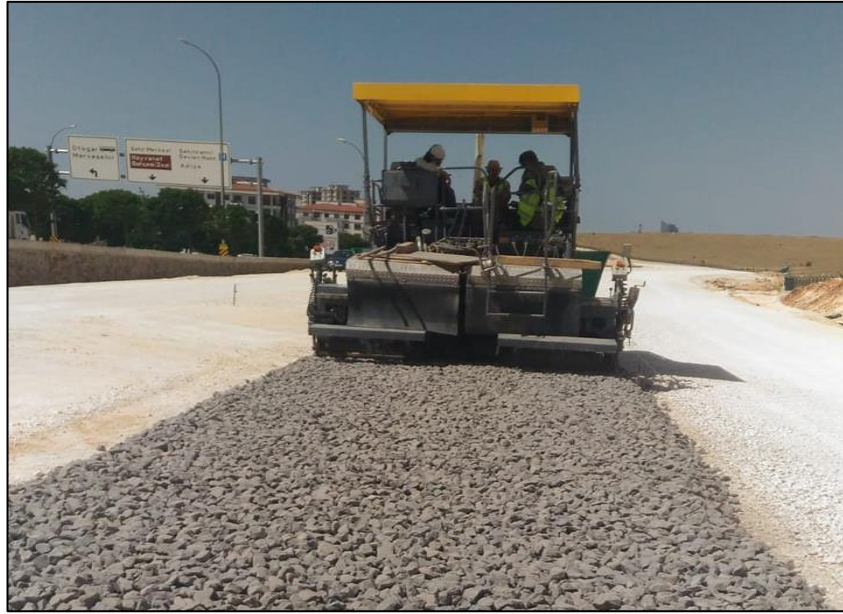
Şekil 2.1. Finisher makinesi ile balast serimi (super 1900).
