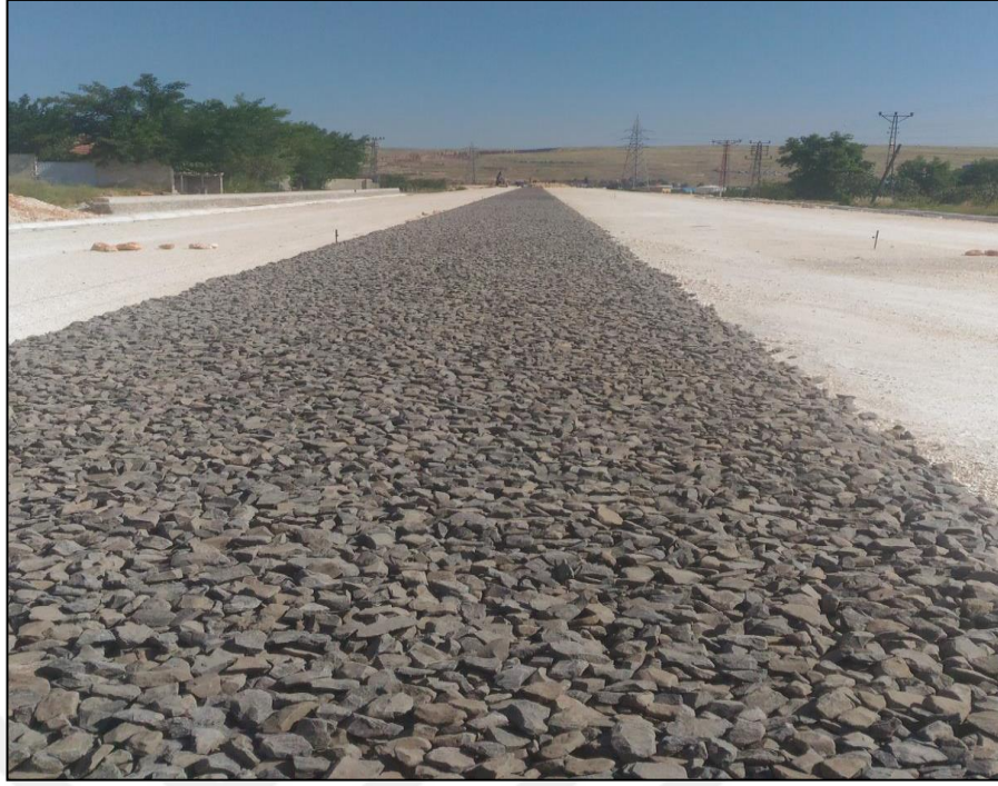
Şekil 1.9. Ray ve traverslerin yerleştirilmesine hazır balast yatağı.
