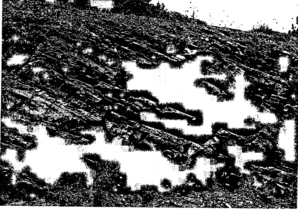
Foto 4.2 : İTÜ göleti dolusavak kazısında kesilen kumtaşı ve silttaşı birimleri
