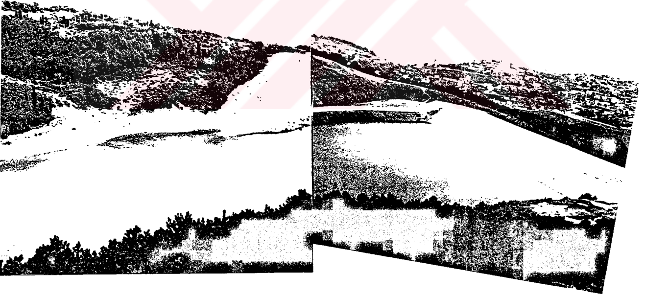
Foto 4.8 : İ.T.Ü. Göletinin kuşbakışı görünümü ve 1/2 oranında oluşturulmuş kazı şevi
