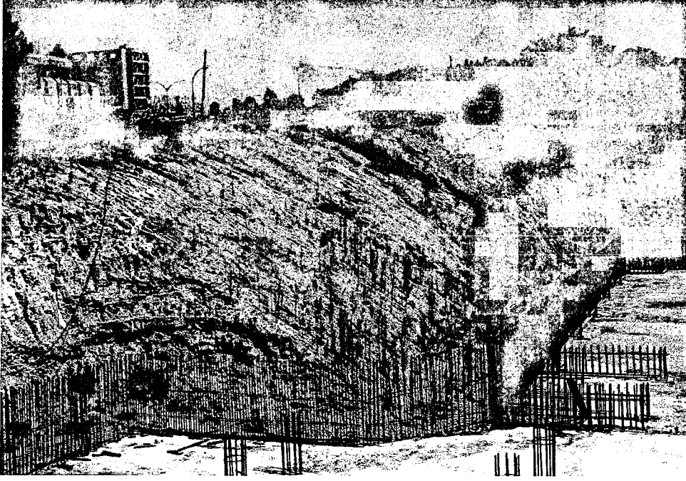
Foto 3.6 : İ.T.Ü. Rektörlük binası temel çukurunda gözlemlenen pliyosen çökelişi
