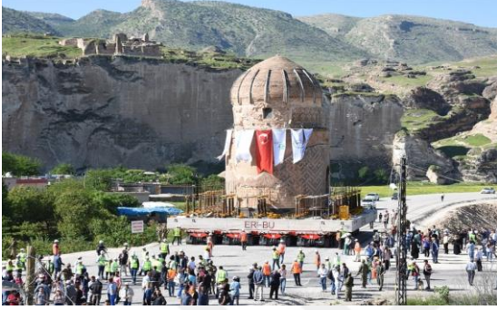
Şekil 2.78 : Batman, Zeynel Bey Türbesi taşınması (URL-38).
