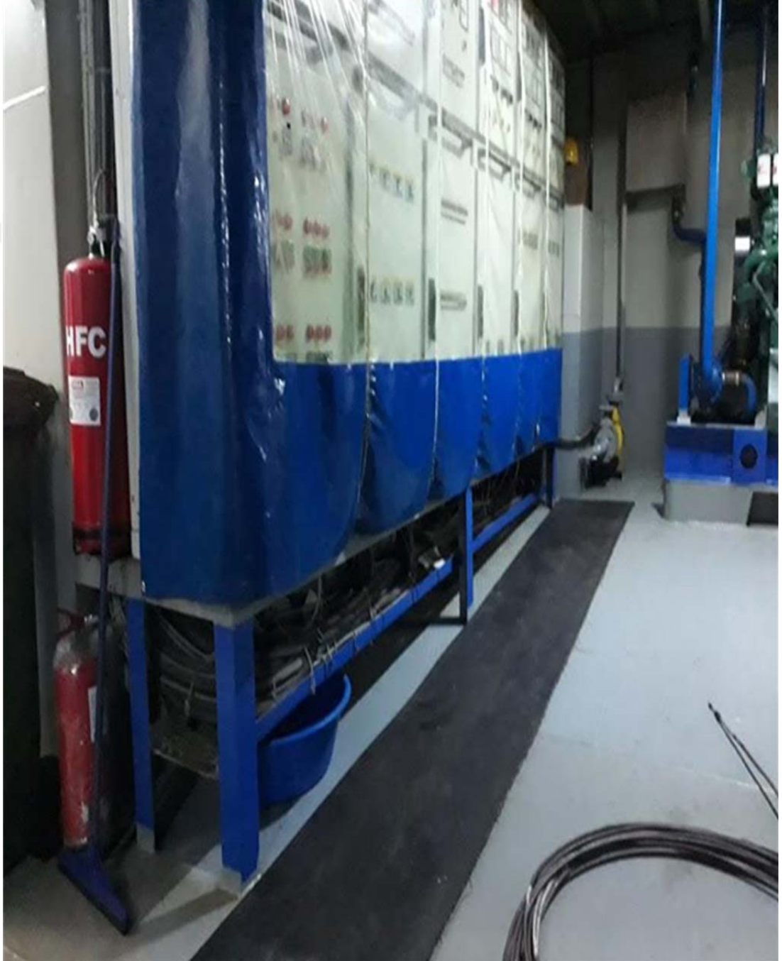
Şekil 4.7.1. Elektrik ana pano yerleşimi
