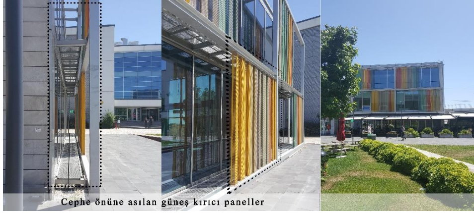
Şekil 5.23: Kütüphane cephesi, güneş kırıcı paneller.
