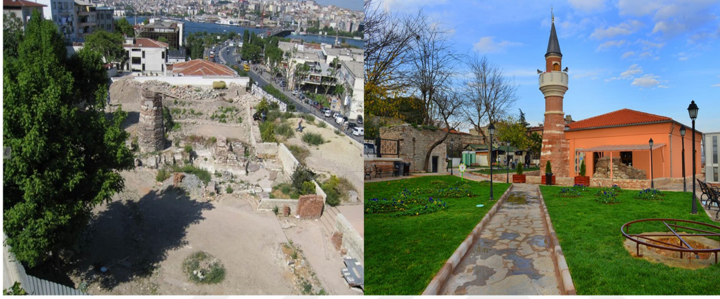
Şekil 4.2 : Piri Mehmet Paşa Cami'nin yapım öncesi ve sonrasındaki durumları [23].
