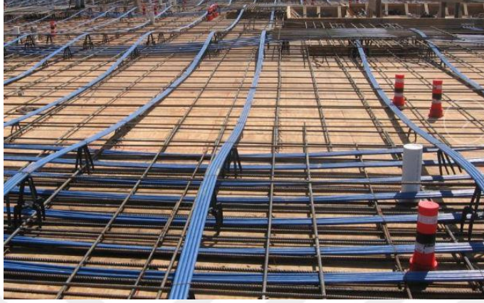
Şekil 5.5 : Aderanssız sistem [6].
