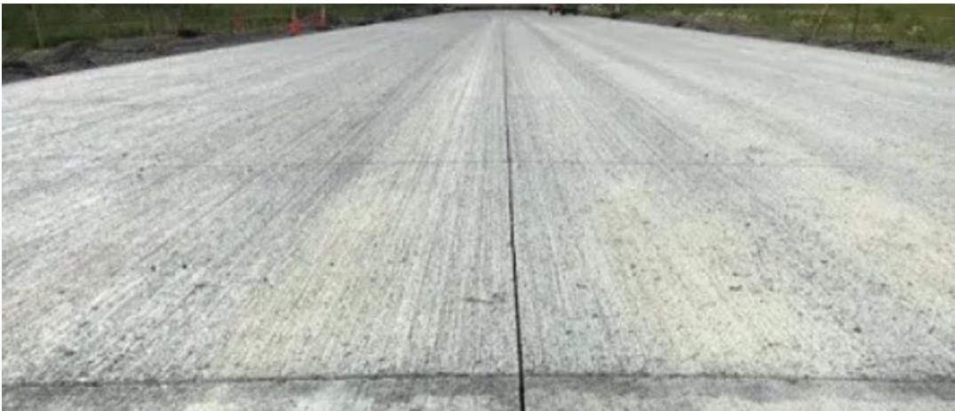
Resim 1.3.2. Doėru uygulanmıř derz kesimi (URL-3, 2023)
