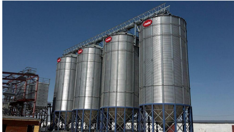
Şekil 2.26 Konik tabanlı çelik silo
