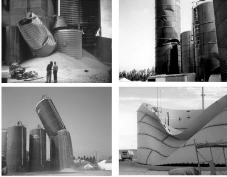
Şekil 2.22 Silo yapım hataları (Carson, 2008; Rotter, 2008)
